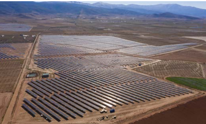
Planta fotovoltaica Huéneja de 150 MW. España.
