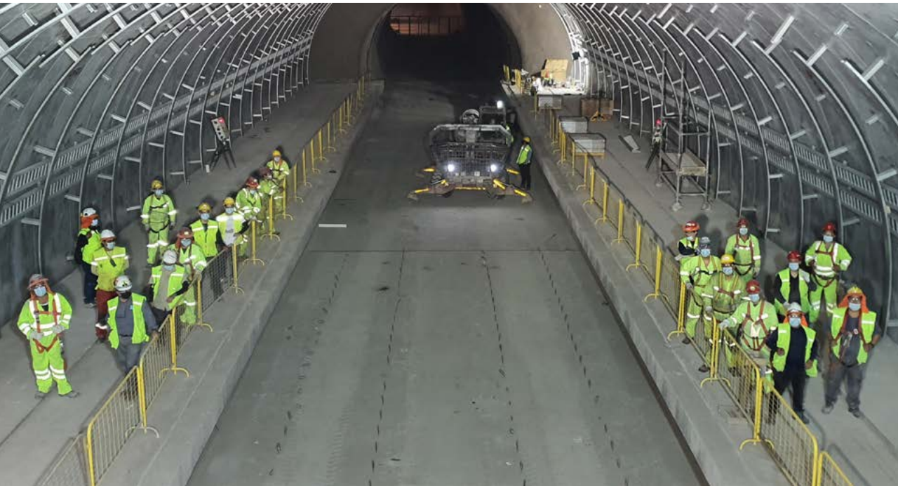
Obras en la Línea 3 del Metro de Santiago. Chile.
