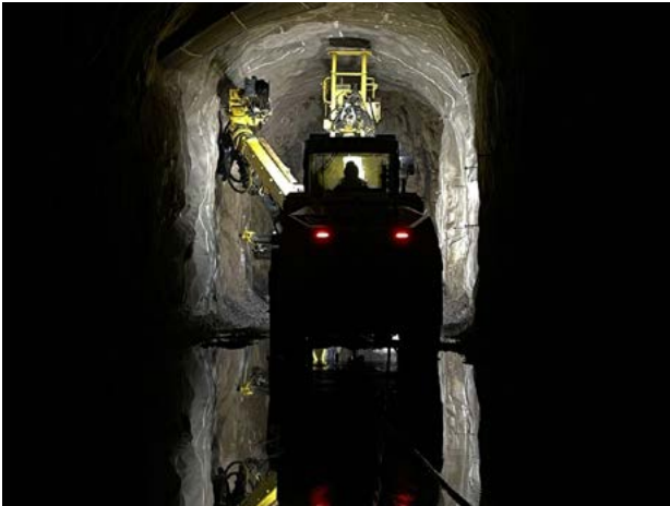
Obras de ampliación de la línea 1 de metro desde la estación de Kungsträdgården, Estocolmo. Suecia.
