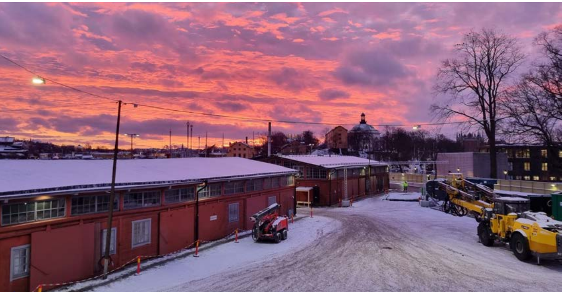
Estación de Kungsträdgården, en el proyecto de ampliación de la Línea Azul del metro de Estocolmo. Suecia.
