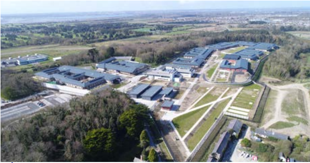
National Forensic Mental Health Hospital (NFMHS) en Portrane, al norte de Dublín. El proyecto ha obtenido la certificación de construcción sostenible de referencia BREEAM Very Good.
