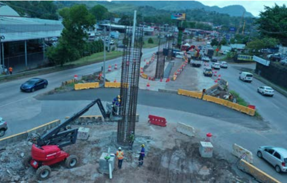
Obras de extensión de la línea 1 del metro. Panamá.
