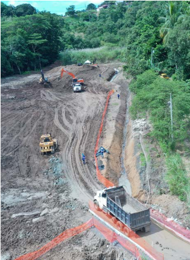
Obras de extensión de la línea 1 del metro. Panamá.
