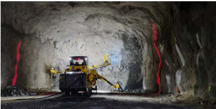
Obras de ampliación de la línea azul del metro de Estocolmo. Estación de Gullmarsplan. Suecia.
