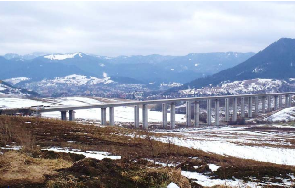
Construcción del tramo Hubová-Ivachnová de la autopista D1. Eslovaquia.
