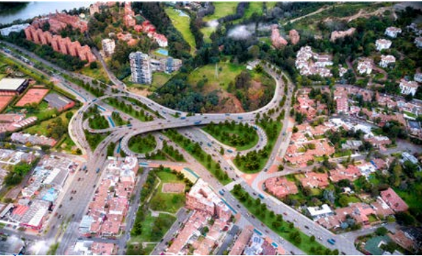
Construcción de la Avenida El Rincón. Colombia.
