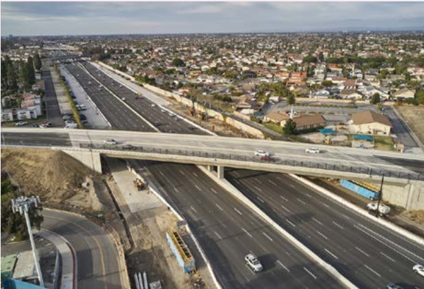
Proyecto de mejora de la I-405 en California, EE. UU.
