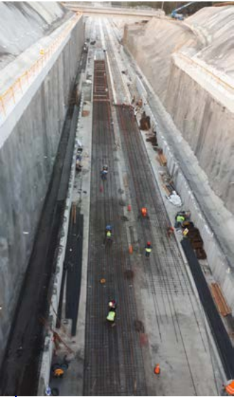
Terracerías 3. Tren interurbano de México-Toluca. México.
