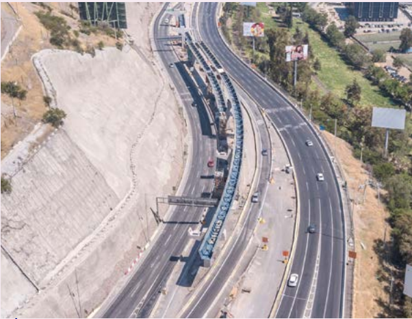
Autopista Américo Vespucio. Chile, una de las mayores infraestructuras viarias de Latinoamérica.
