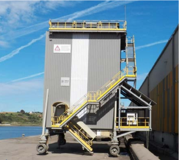
Tolva autopropulsada OHLA, en el Puerto de Avilés, Asturias. España.
