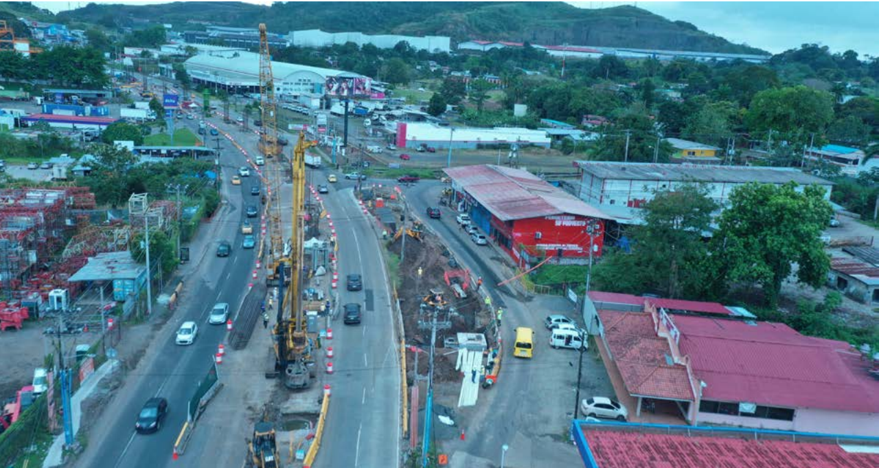
Obras de extensión de la línea 1 del metro. Panamá.
