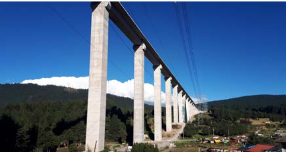
Viaducto 4. Tren interurbano de México-Toluca. México.
