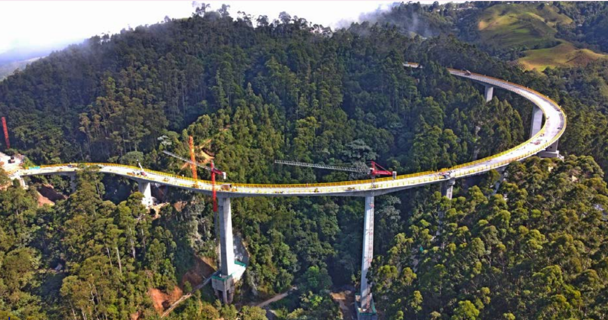
Puente la Herradura-Yarumo Blanco del Proyecto Cruce de la Cordillera Central. Colombia.
