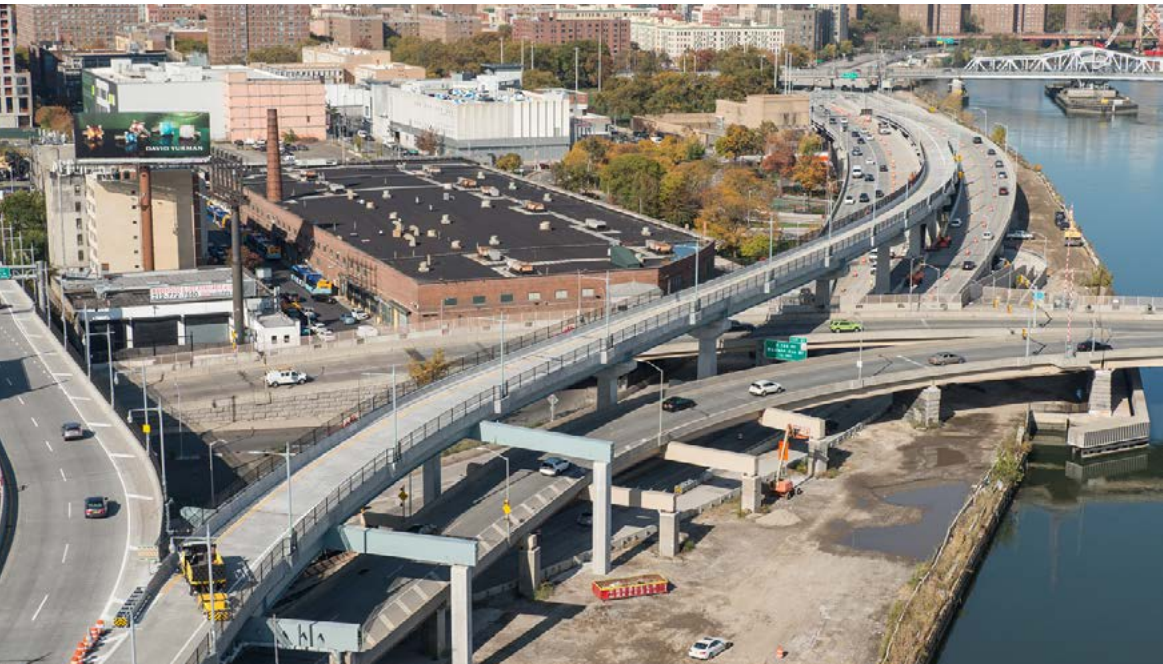
Rampa de acceso en el puente Robert F. Kennedy en Nueva York. EE. UU.
