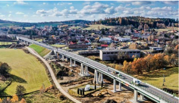
Modernización de la línea ferroviaria de Sudoměřice-Votice. República Checa.
