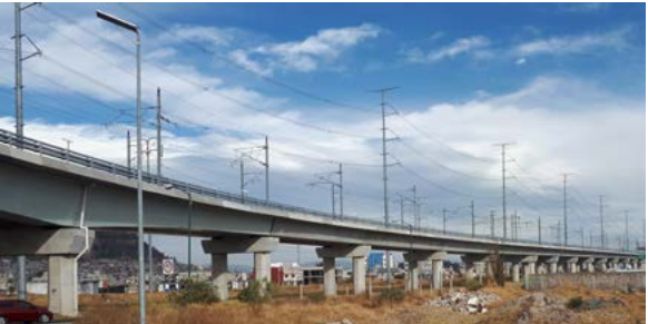
Viaducto 6. Tren interurbano de México-Toluca. México.
