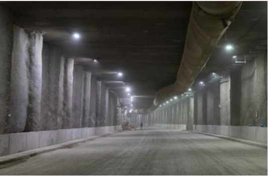
Túnel híbrido en la Concesión AVO I, Santiago de Chile. Chile
