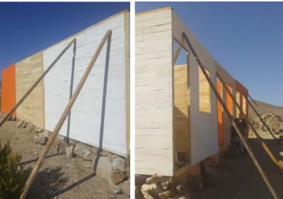
Construcción de casetas con madera reutilizada.
