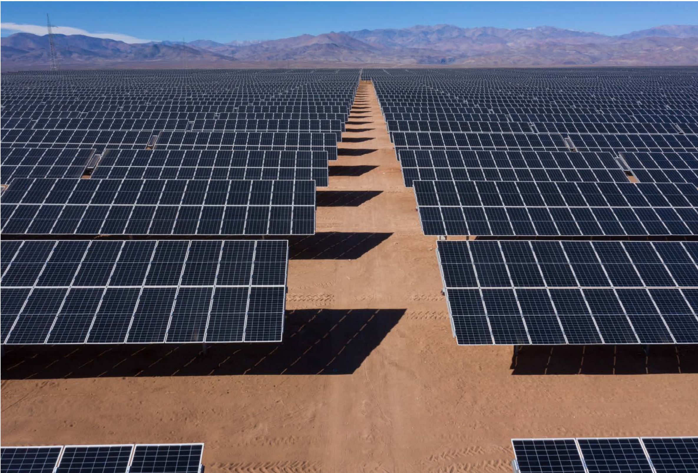
Planta fotovoltaica La Huella. Chile.
