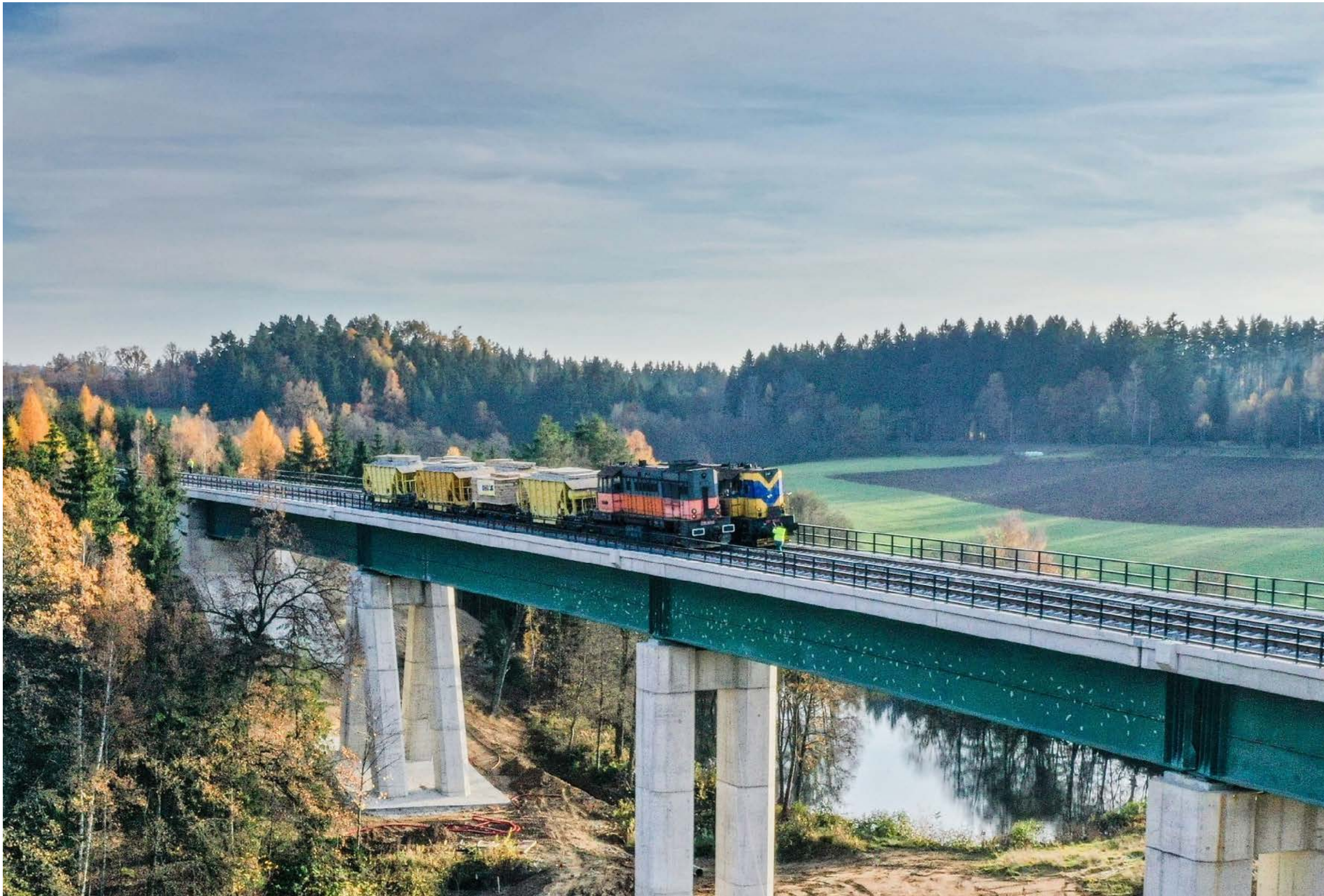
Modernización de la línea ferroviaria de Sudoměřice-Votice. República Checa.
