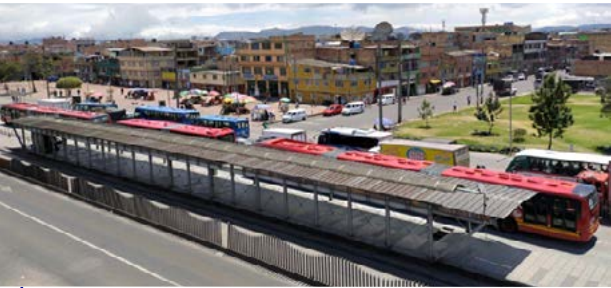
Proyecto Avenida Ciudad de Cali. Estación de Transmilenio. Colombia.
