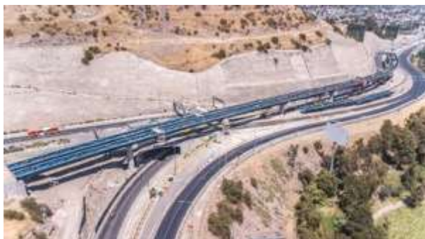
Autopista urbana Américo Vespucio, viaducto El Salto, Chile.
