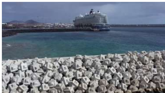
Cubipods. Contradique Sur Muelle de Cruceros Naos. Puerto de Las Palmas, Islas Canarias. España.
