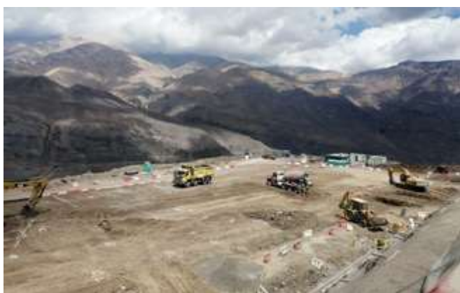
Movimiento de tierras en la mina Teniente, Chile.
