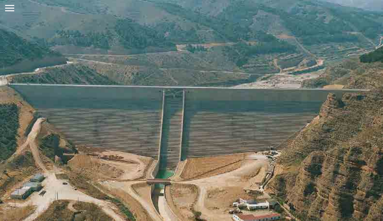
^ Presa del Val. España. Val Dam. Spain.
