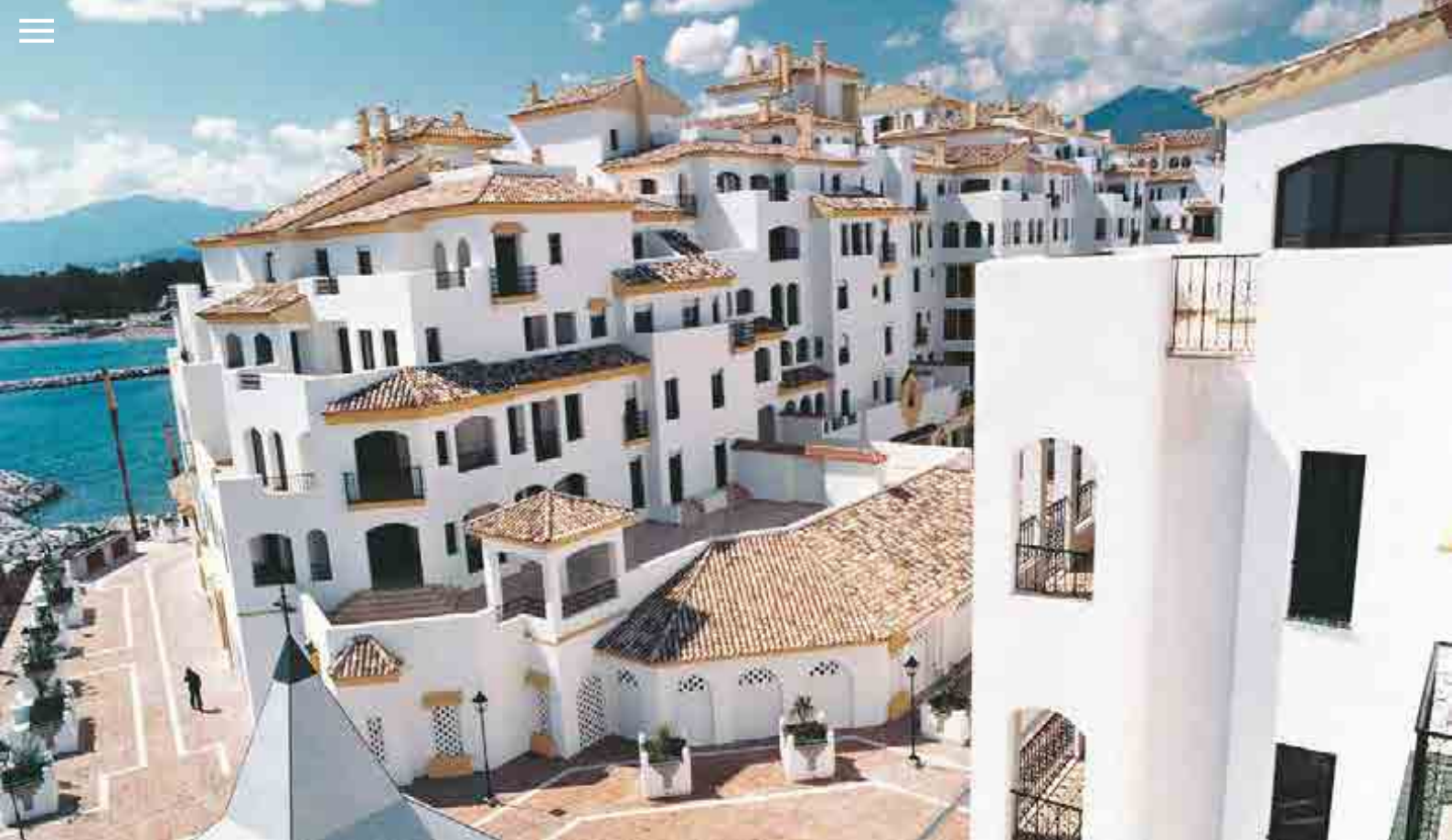
^ Muelle de Benabola. Málaga. España. Benabola Quay. Málaga. Spain.
