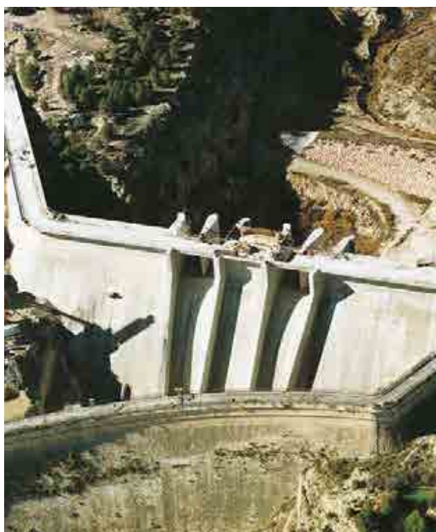
^ Presa de Puentes. España. Puentes Dam. Spain.
