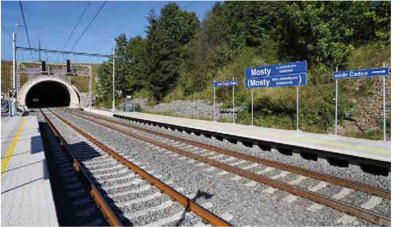
^ Corredor ferroviario. Línea Bohumín-Čadca-III. Tramo Bystrice nad Olší-Česky Těšín. República Checa. Railway Corridor. Bohumin-Čadca-III line. Bystrice nad Olší-Česky Těšín section. Czech Republic.
