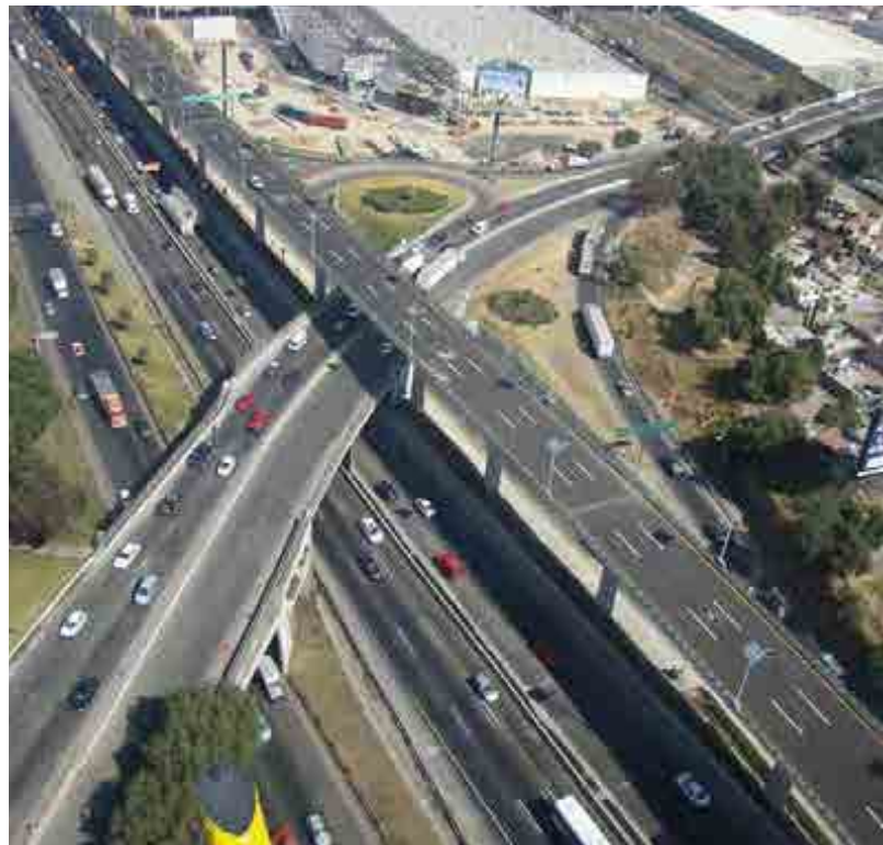
^ Viaducto Elevado Bicentenario. México. Bicentennial Elevated Viaduct. Mexico.
