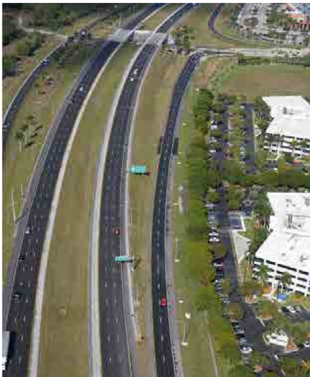
^ Autopista Sawgrass Miami. Florida. Estados Unidos. Sawgrass Miami Toll Road. Florida. United States.
