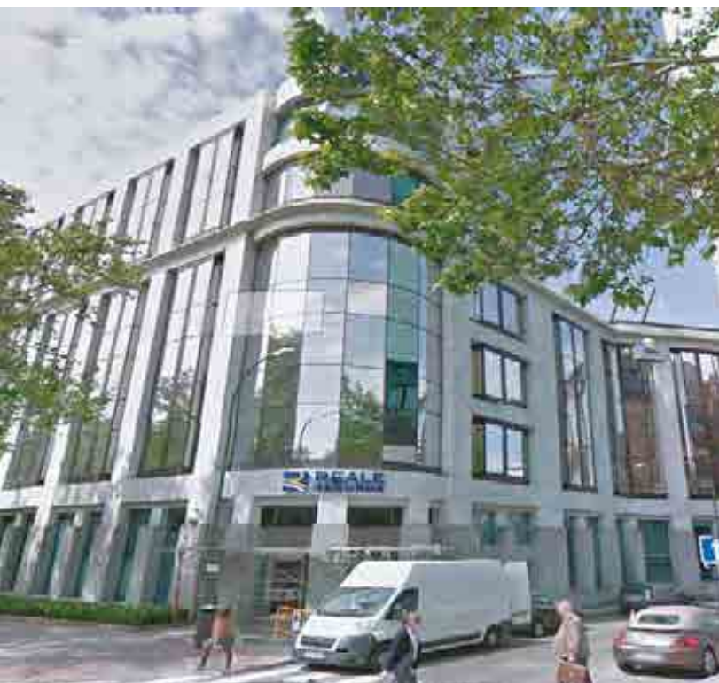
^ Sede corporativa Reale Seguros. Rehabilitación. Madrid. España. Corporate headquarters Reale Seguros. Repair. Madrid. Spain.
