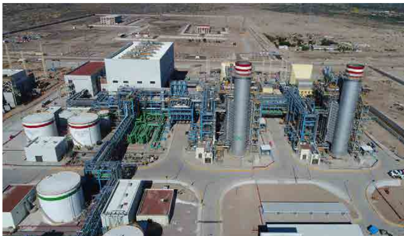
^ Central de Ciclo Combinado de 770 MW Empalme I. México. Empalme I 770 MW Combined Cycle power plant. Mexico.
