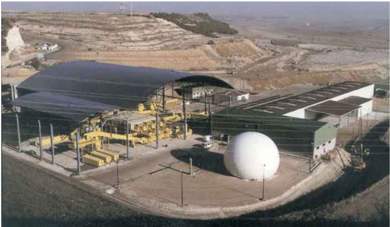
^ Planta de biometanización, Valladolid, España. Biomethanization plant, Valladolid, Spain.
