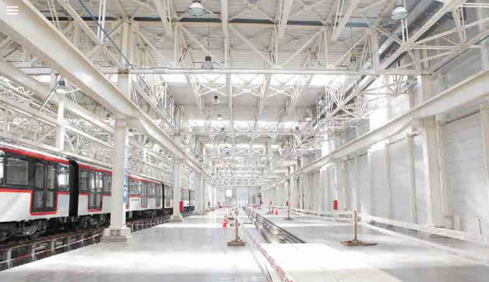
^ Metro de Santiago de Chile. Línea 6. Talleres y Cocheras. Chile. Metro de Santiago de Chile. Line 6. Workshops and Depots. Chile.
