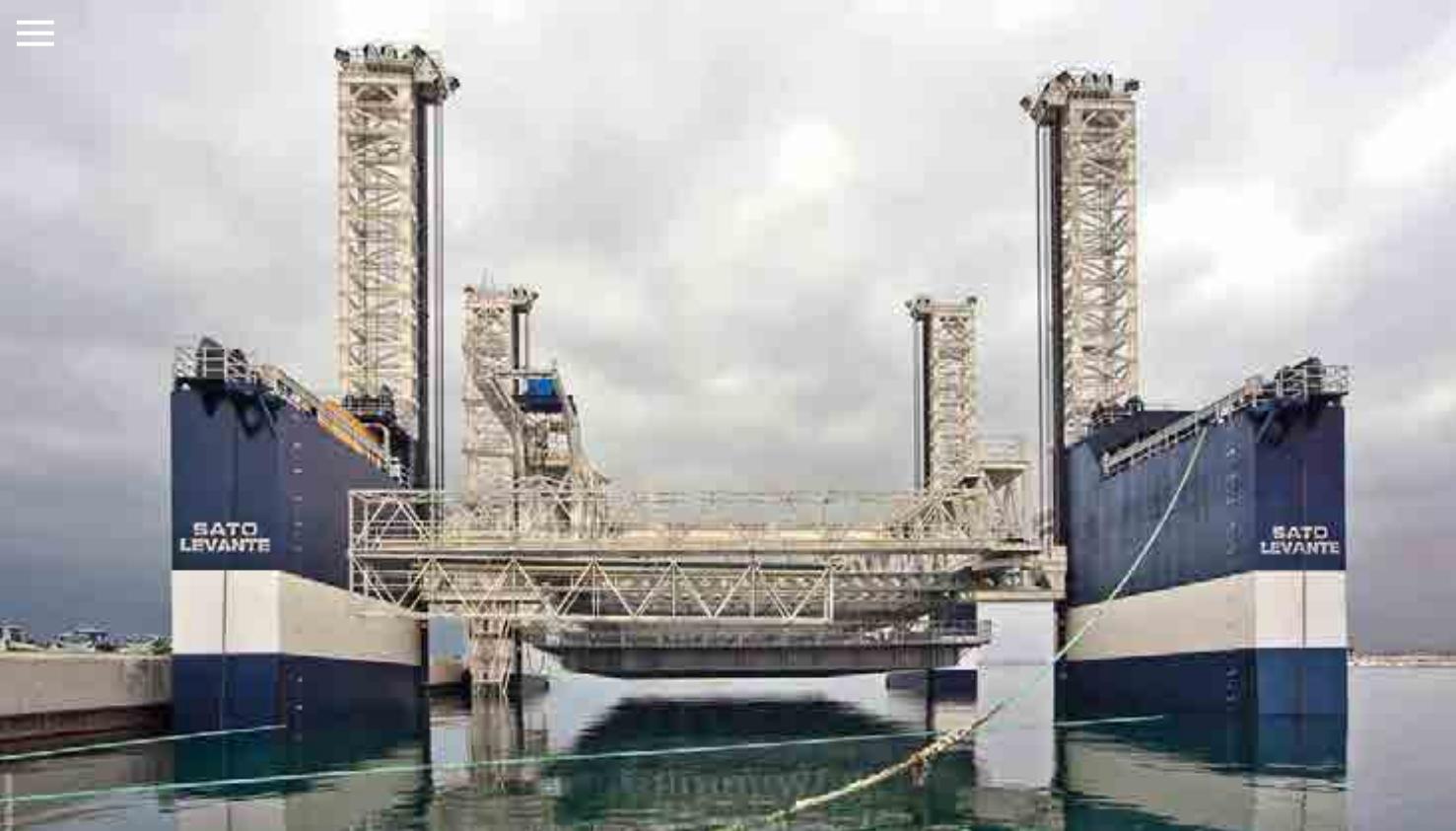
^ SATO Levante. Dique flotante. España SATO Levante. Floating dock. Spain.
