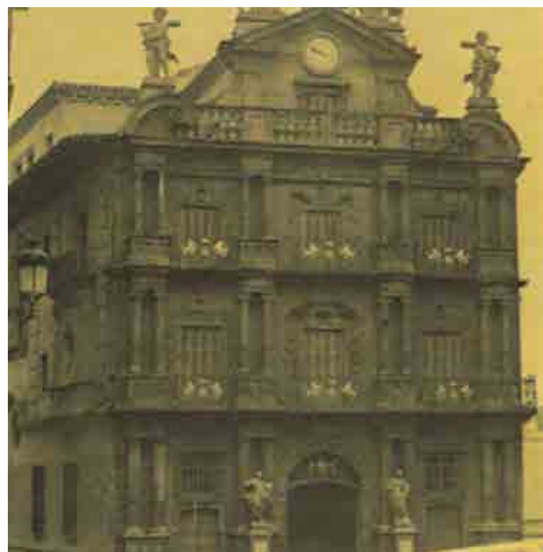
^ Ayuntamiento de Pamplona. Fachada. España. Pamplona City Hall. Facade. Spain.
