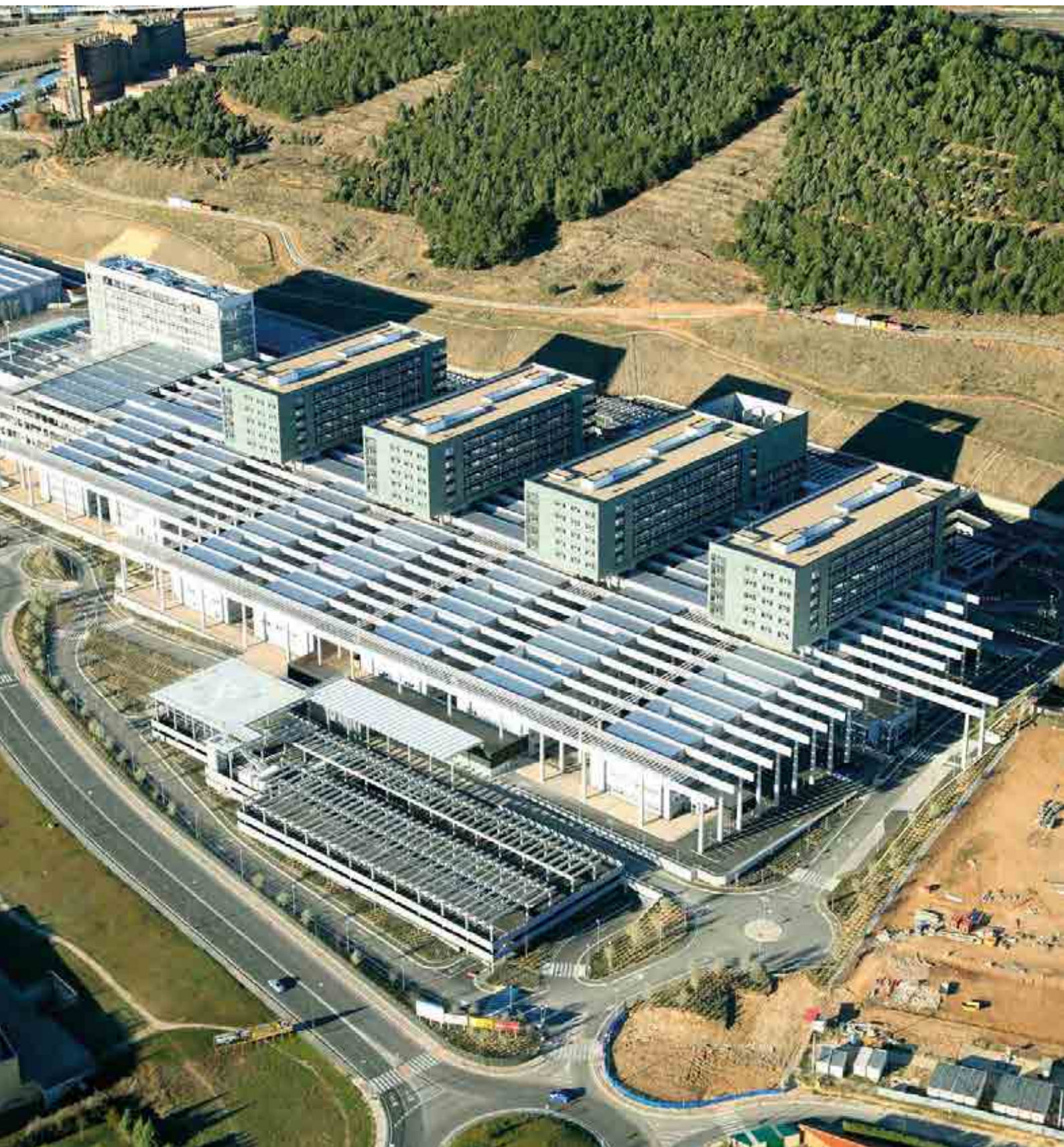
^ Hospital Universitario de Burgos. España. Burgos University Hospital. Spain.
