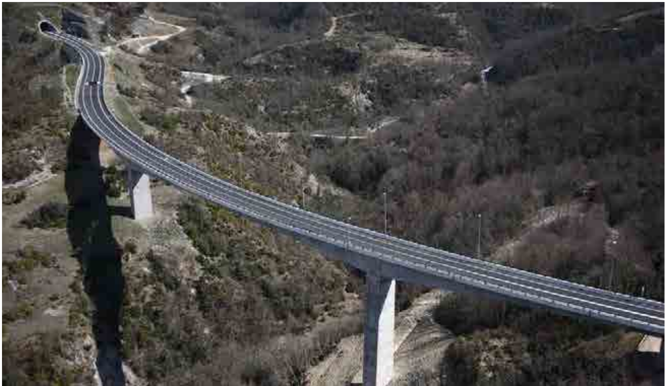
^ Carretera Vic-Olot. Túnel Bracons. España. Vic-Olot Road. Bracons Tunnel. Spain.
