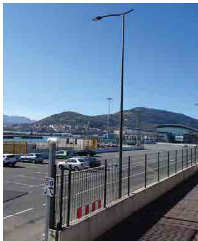
^ Puerto de Bilbao. Muelle adosado al contradique de Algorta. España Port of Bilbao. Quay attached to the harbor wall of Algorta. Spain.
