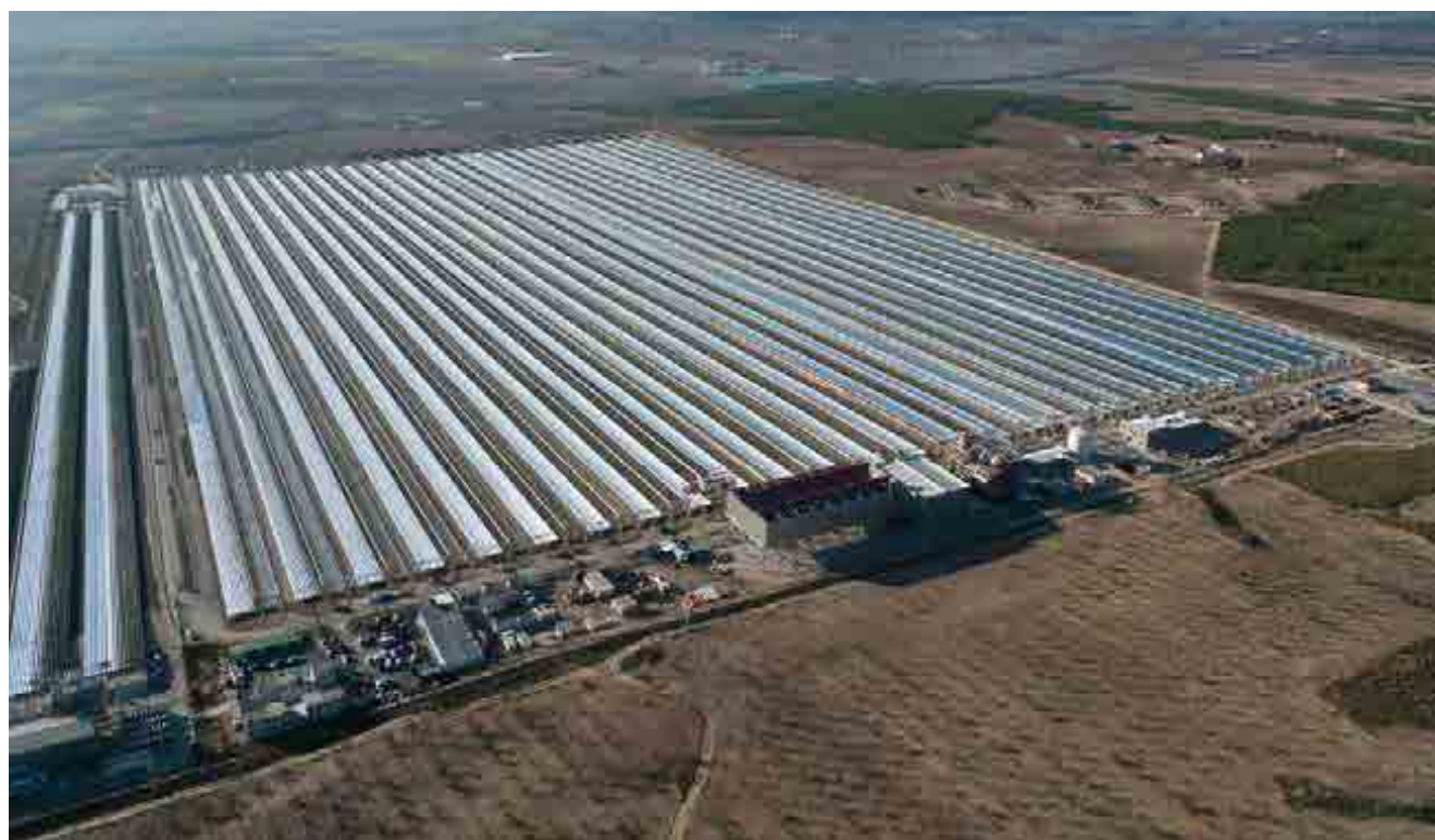
^ Planta termosolar Puerto Errado 2. Calasparra. España. Solar thermal plant Puerto Errado 2. Calasparra. Spain.
