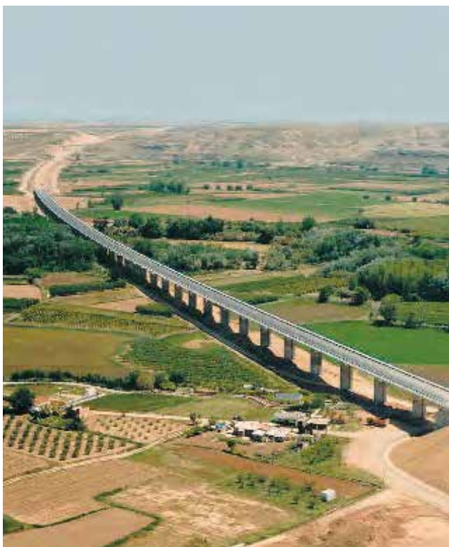
^ Viaducto sobre el río Jalón. AVE Madrid-Zaragoza. España. Viaduct over the Jalón River. HSR Madrid-Zaragoza. Spain.
