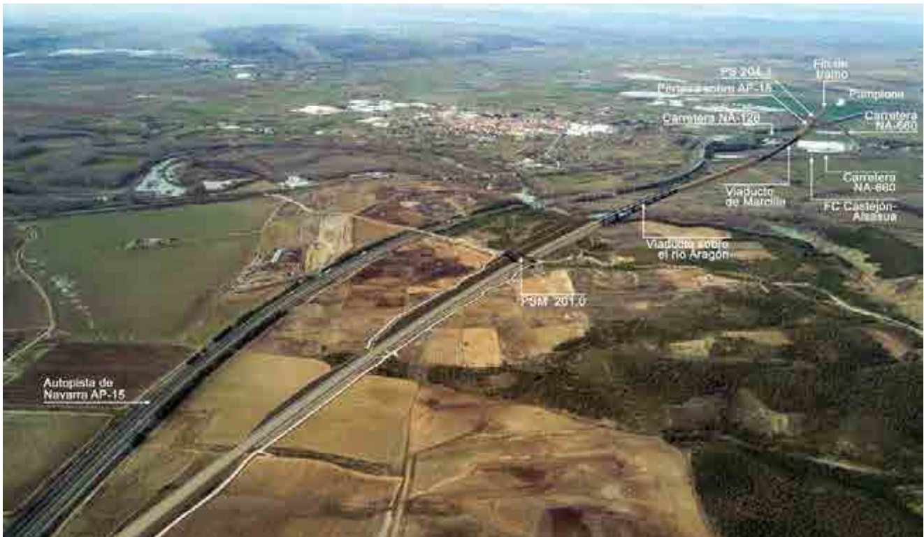
^ LAV Zaragoza-Pamplona. España. Zaragoza-Pamplona HSR. Spain.
