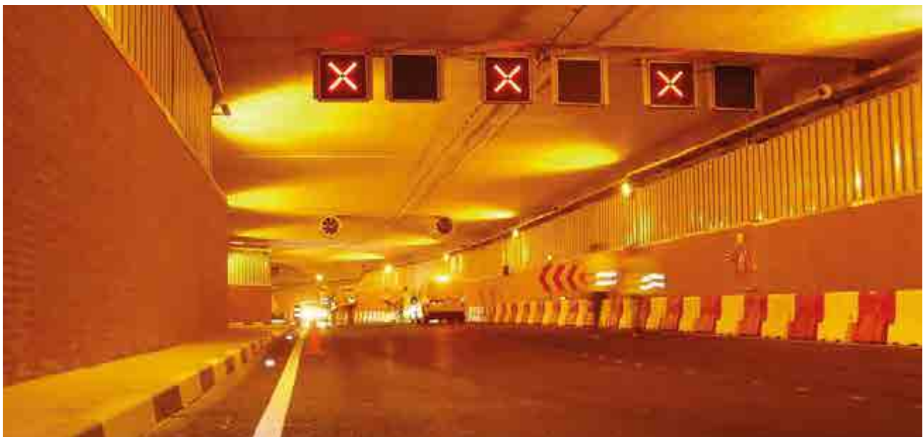
^ Túnel Avenida Pío XII. Madrid. España. Pío XII Avenue Tunnel. Madrid. Spain.
