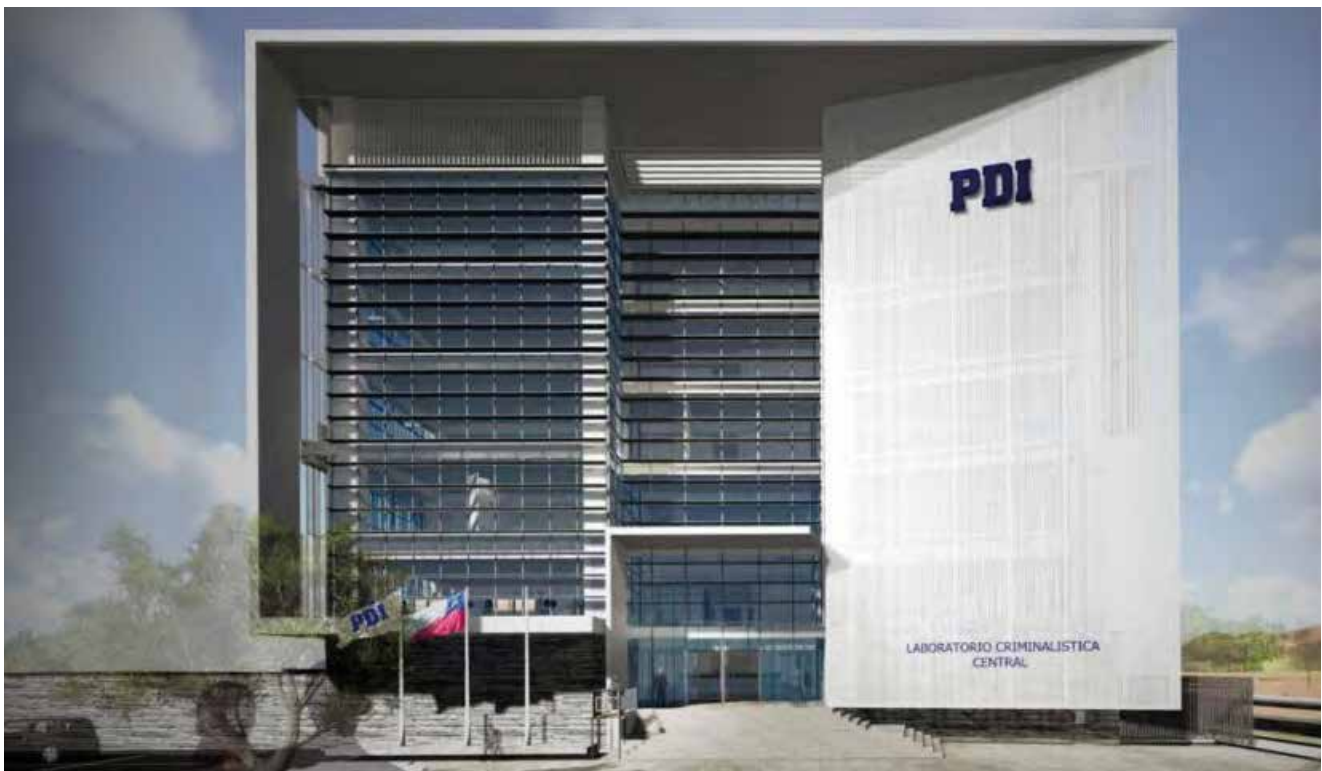
^ Edificio Laboratorio Criminalística Policía de Investigaciones (PDI). Santiago de Chile. Chile. Investigation Police (PDI) Criminalistic Laboratory building. Santiago de Chile. Chile.
