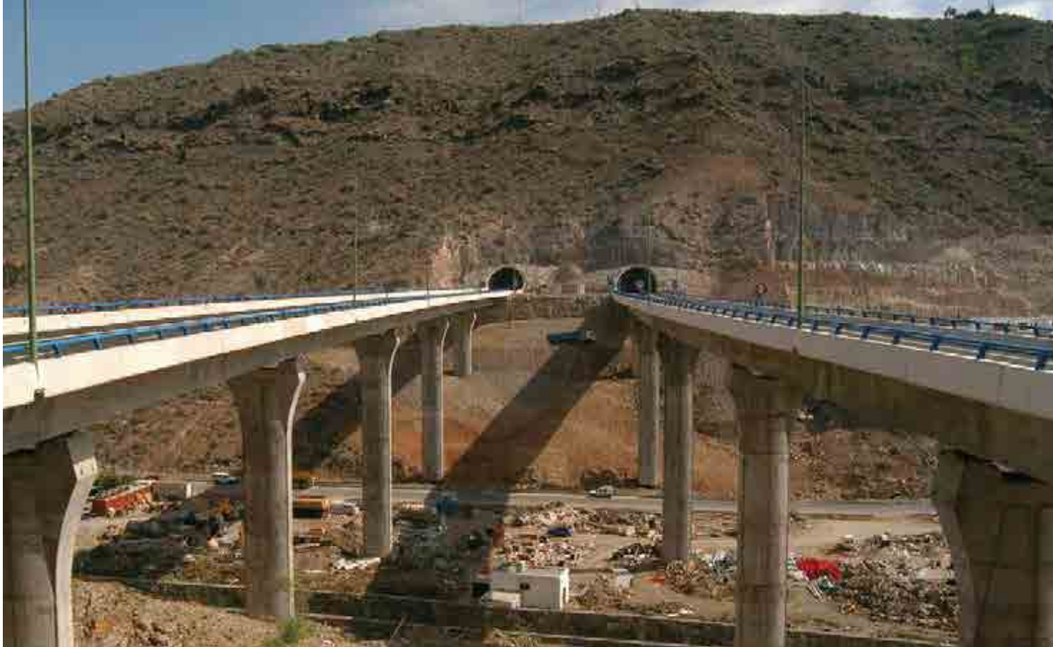
^ Túneles autopista GC-1. Tramo Arguineguín-Puerto Rico. España. Tunnels of the GC-1 Toll Road. Arguineguín-Puerto Rico section. Spain.
