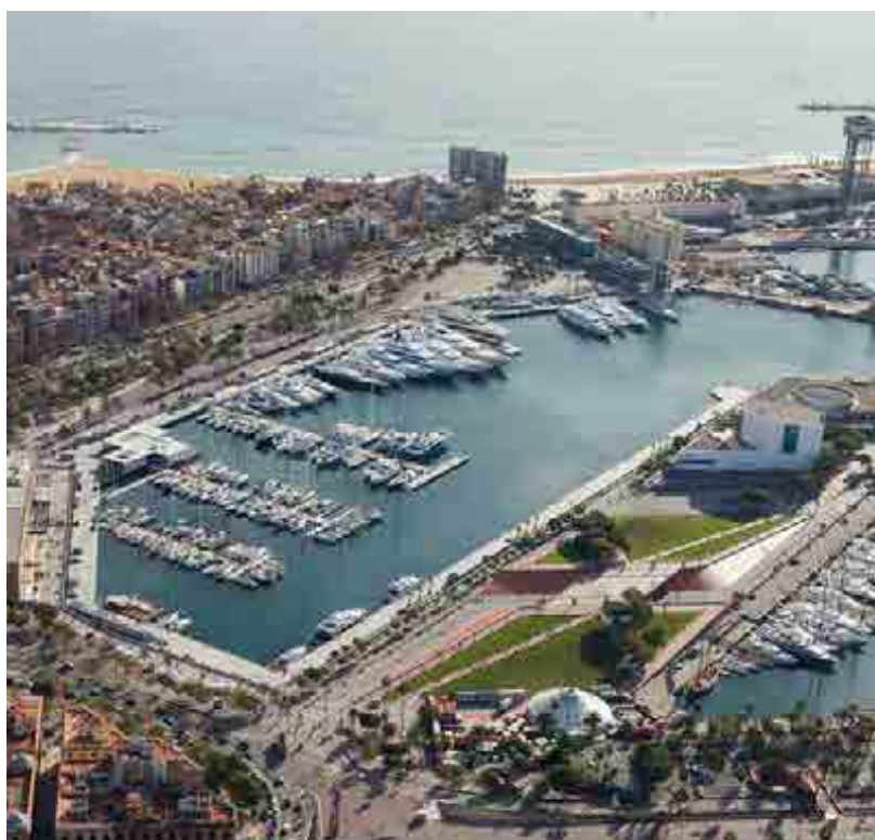
^ Puerto de Barcelona. Port Vell. Rehabilitación y mejora de la marina. España. Port of Barcelona. Port Vell. Rehabilitation and improvement of the marina. Spain.
