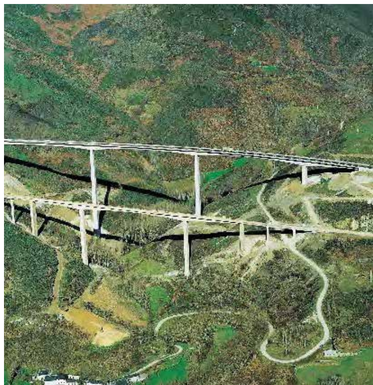
^ Viaducto de Las Lamas. Carretera N-VI. España. Las Lamas Viaduct. N-VI Road. Spain.
