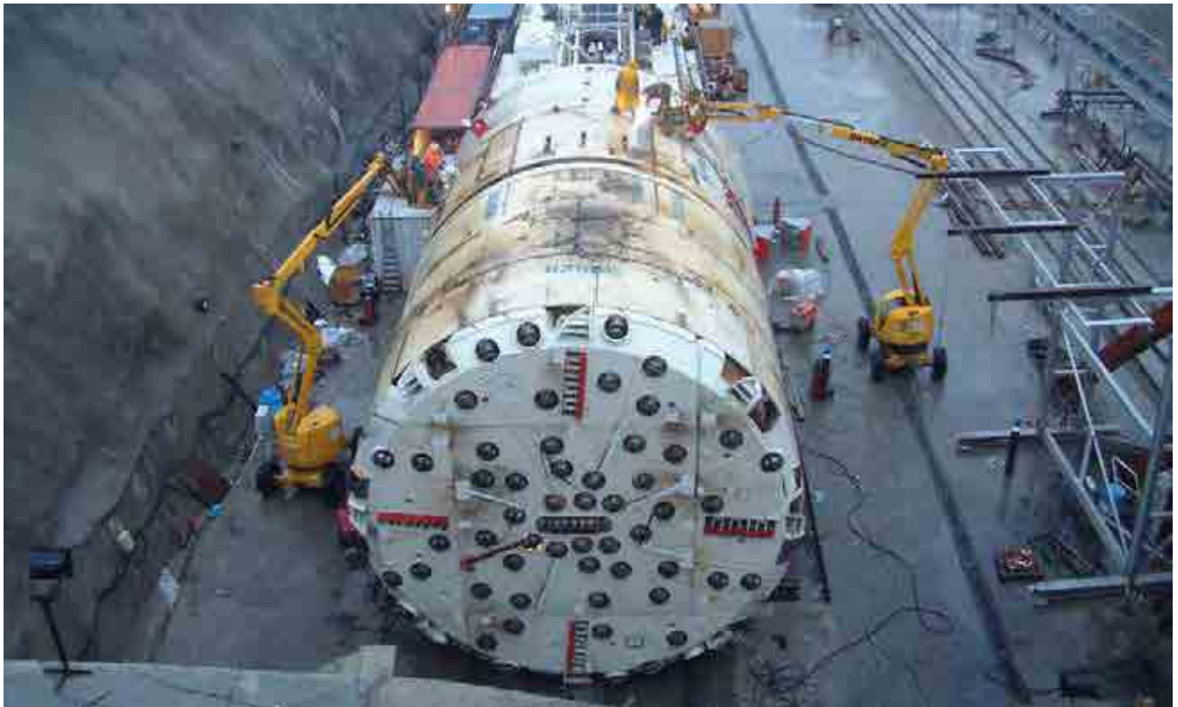
^ Tuneladora del túnel de Guadarrama. España. Guadarrama Tunnel boring machine. Spain.
