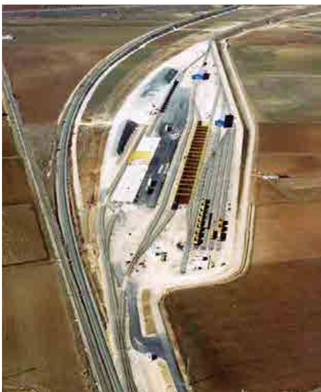
^ LAV Córdoba-Málaga. Montaje de línea. España. Córdoba-Málaga HSR line. Installation. Spain.
