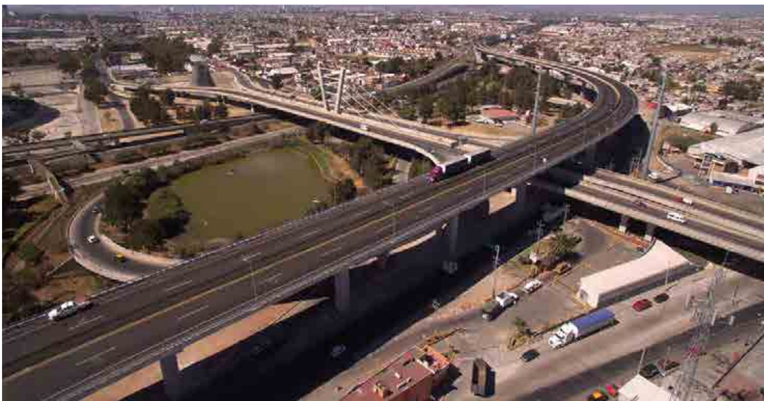
^ Libramiento elevado Puebla. México. Puebla elevated Bypass. Mexico.
