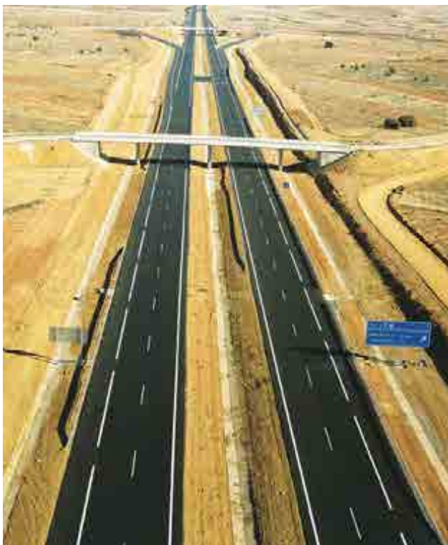
^ Autopista A-52. Tramo Benavente-Camarzana del Tera. España. A-52 Toll Road. Benavente-Camarzana del Tera section. Spain.
