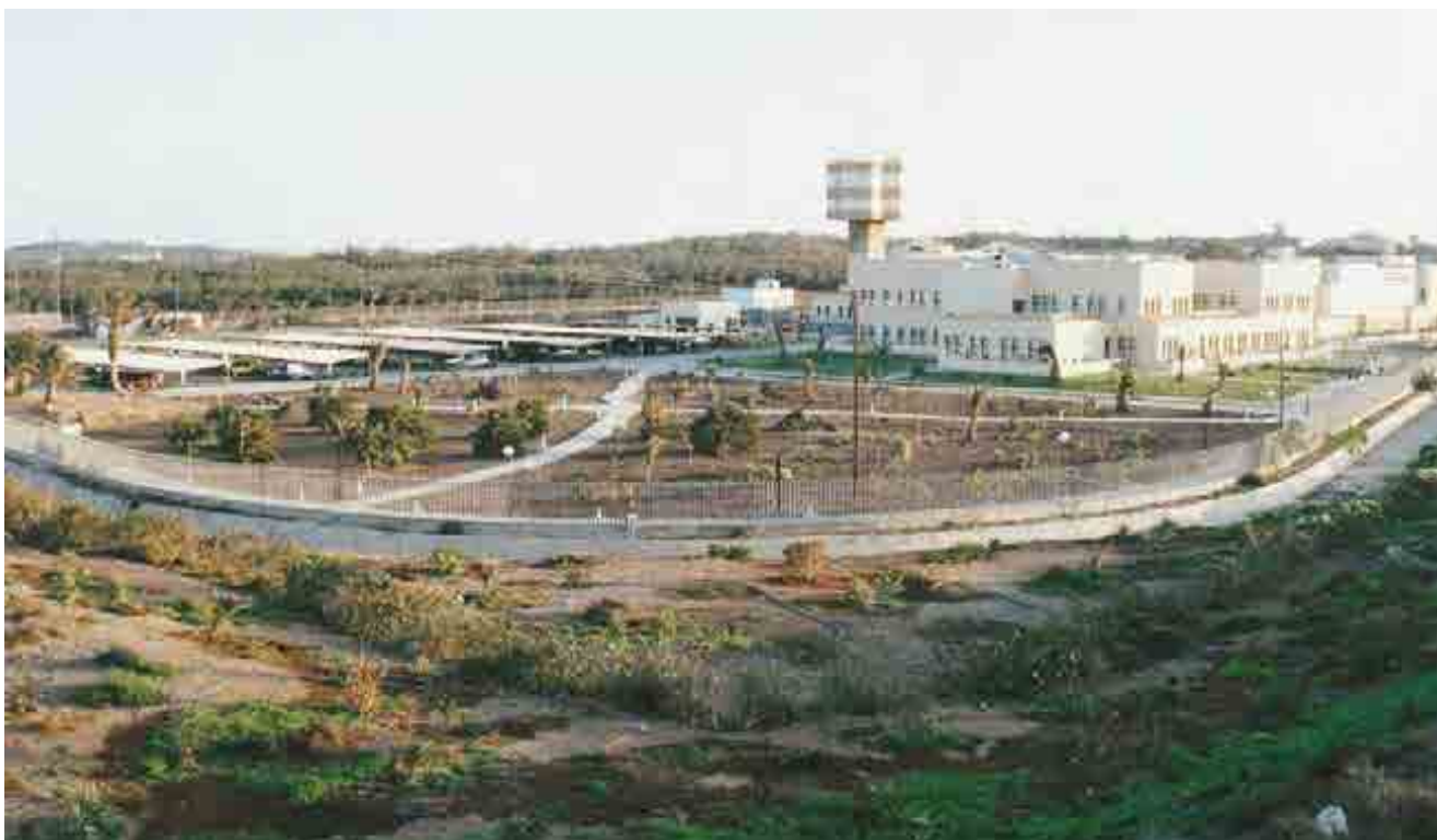
^ Aeropuerto de Gran Canaria. Centro de Control. España. Gran Canaria Airport. Control Center. Spain.
