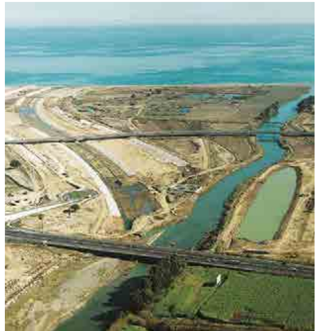
^ Río Guadalhorce. Encauzamiento. España. Guadalhorce River. Channeling. Spain.
