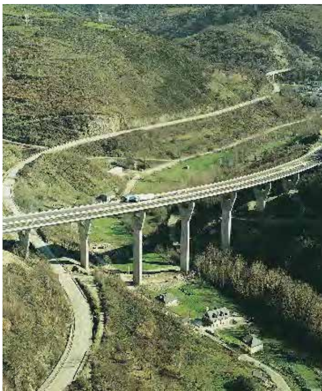
^ Viaducto Vega de Valcárcel. Carretera N-VI. España. Vega de Valcárcel Viaduct. N-VI Road. Spain.
