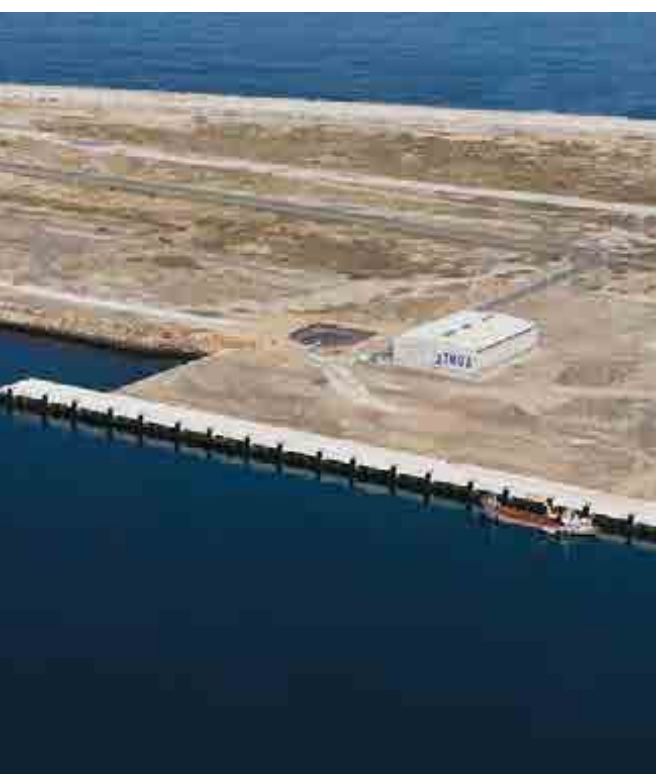
^ Puerto Exterior de A Coruña. Dique Oeste y rellenos de explanada de Ribera. Nuevas instalaciones portuarias en Punta Langosteira. España. Outer Port of A Coruña. West Quay and fillings of the Ribera esplanade. New port facilities in Punta Langosteira. Spain.
