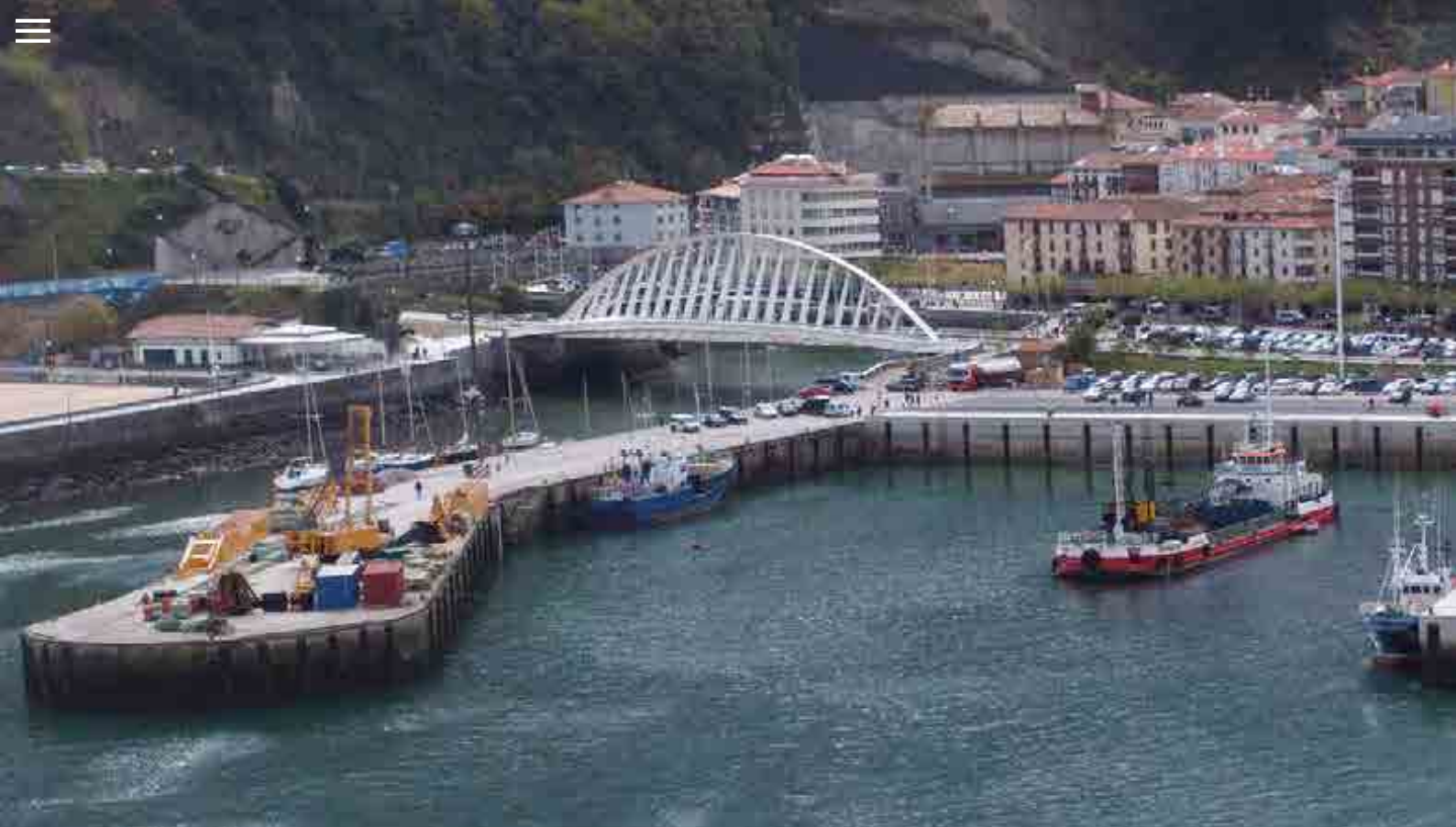
^ Puerto de Ondárroa. Remodelación de muelles en el A.I.1. España. Port of Ondárroa. Remodelling of quays in the A.I.1. Spain.
