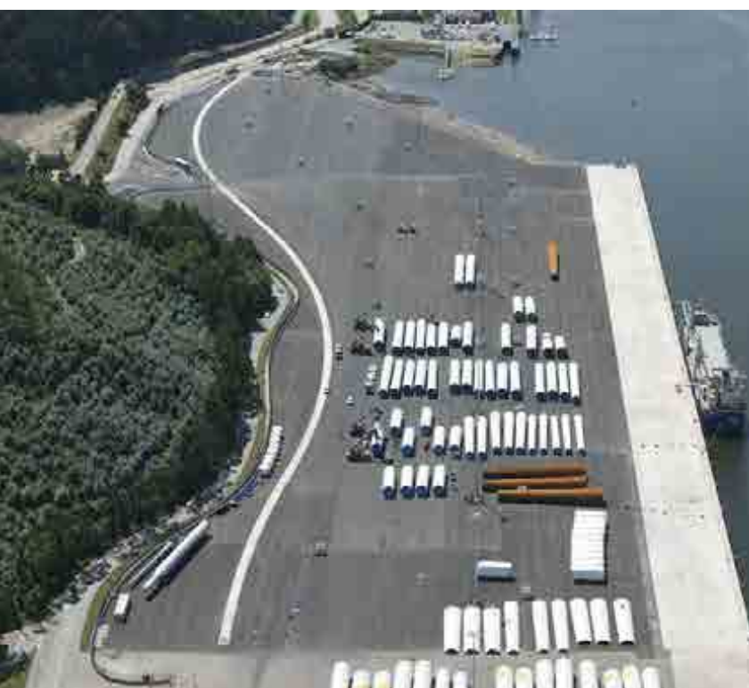
^ Puerto de Avilés. Ampliación. España. Port of Avilés. Enlargement. Spain.
