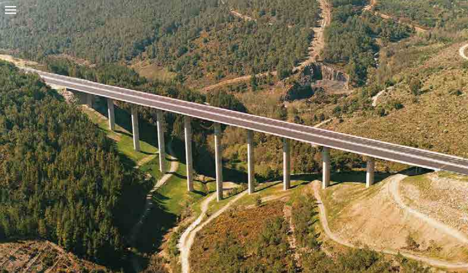
^ Viaducto de Santa Marta. Autovía de las Rías Bajas. Tramo Fumaces-Estivadas. España. Santa Marta Viaduct. Rías Bajas Expressway. Fumaces-Estivadas section. Spain.
