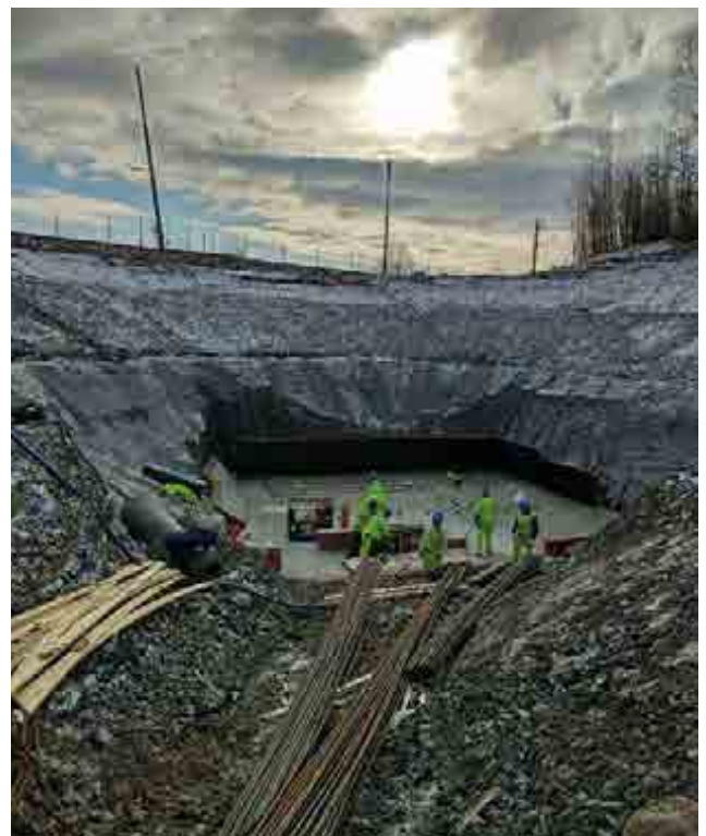
^ Línea ferroviaria Lund-Arlöv. Suecia. Lund-Arlöv railway line. Sweden.
