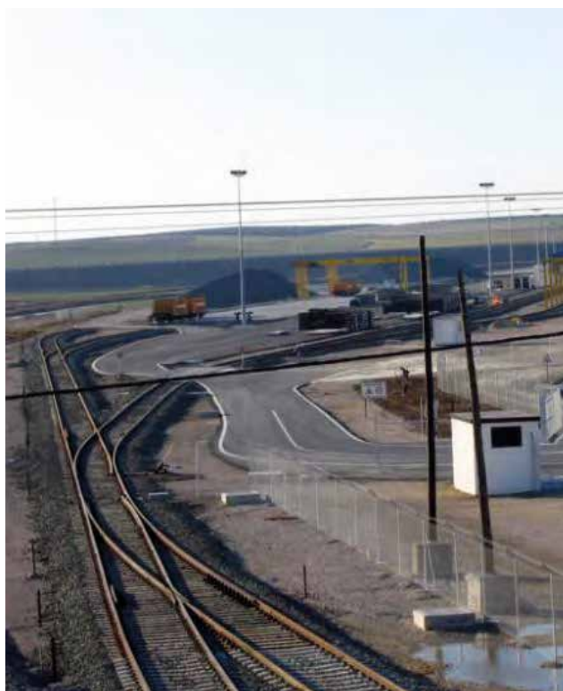
^ LAV Córdoba-Málaga. Montaje de vía e instalaciones. Tramo Antequera-Málaga. España. Córdoba-Málaga HSR. Track assembly and facilities. Antequera-Málaga section. Spain.
