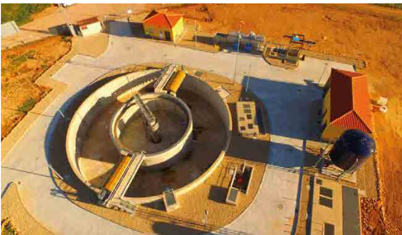
^ EDAR de Barrax. España. Barrax WWTP. Spain.
