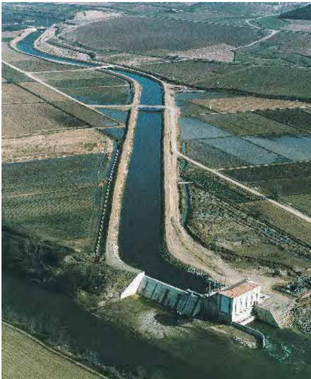
^ Central hidroeléctrica de Arlas. Navarra. España. Hydroelectric power station of Arlas. Navarra. Spain.
