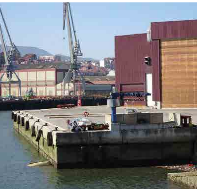
^ Puerto de Bilbao. Aumento de calado y refuerzo del muelle de Axpe. España. Port of Bilbao. Increase in draught and reinforcement of the Axpe quay. Spain.
