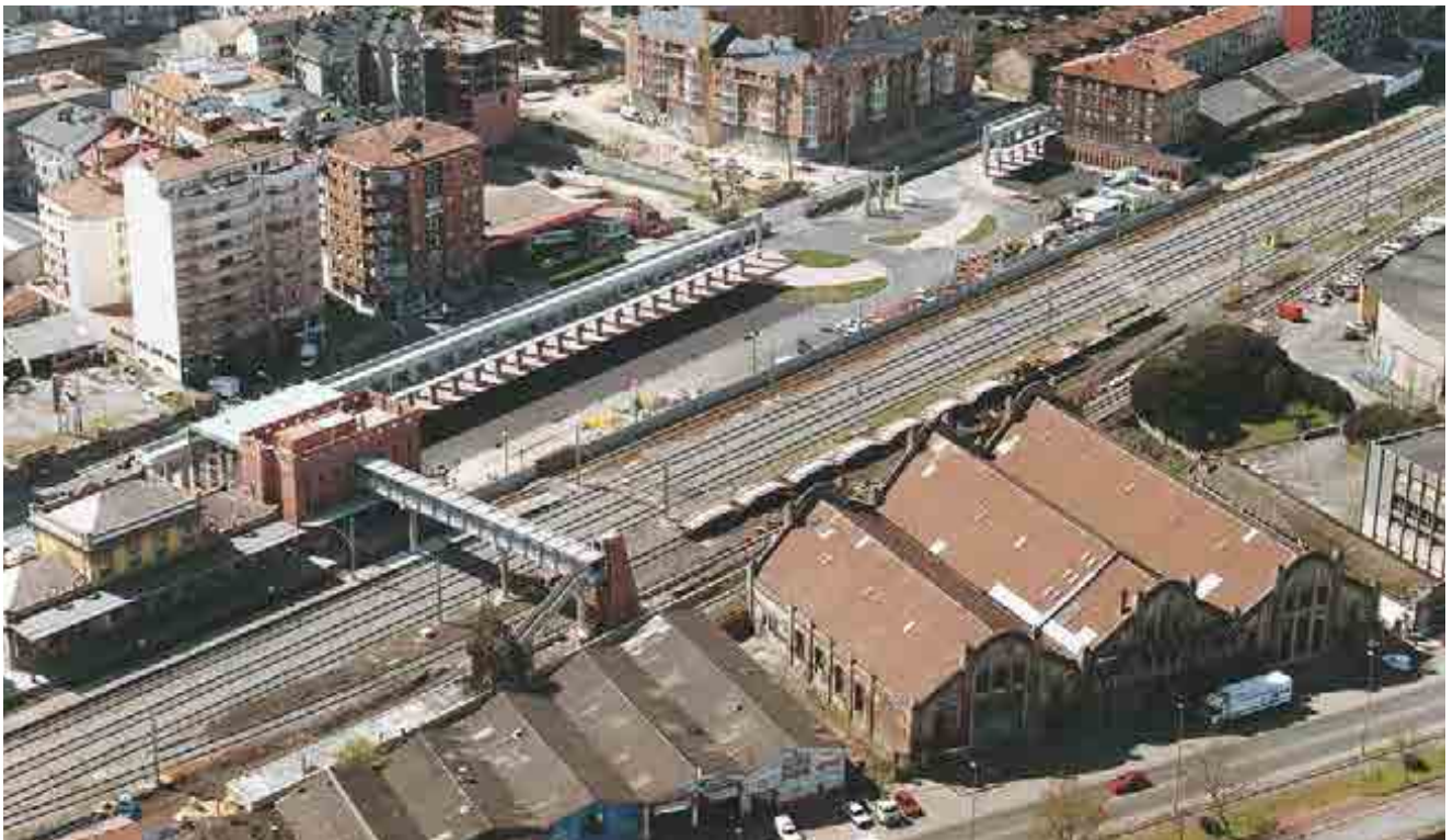
^ Estación intermodal de transportes. Avilés. España. Intermodal Transport Station. Avilés. Spain.
