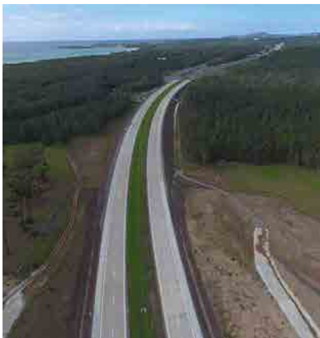
^ Autopista del Pacífico. Tramo Woolgoolga a Ballina. Australia. Pacific Expressway. Woolgoolga-Ballina section. Australia.
