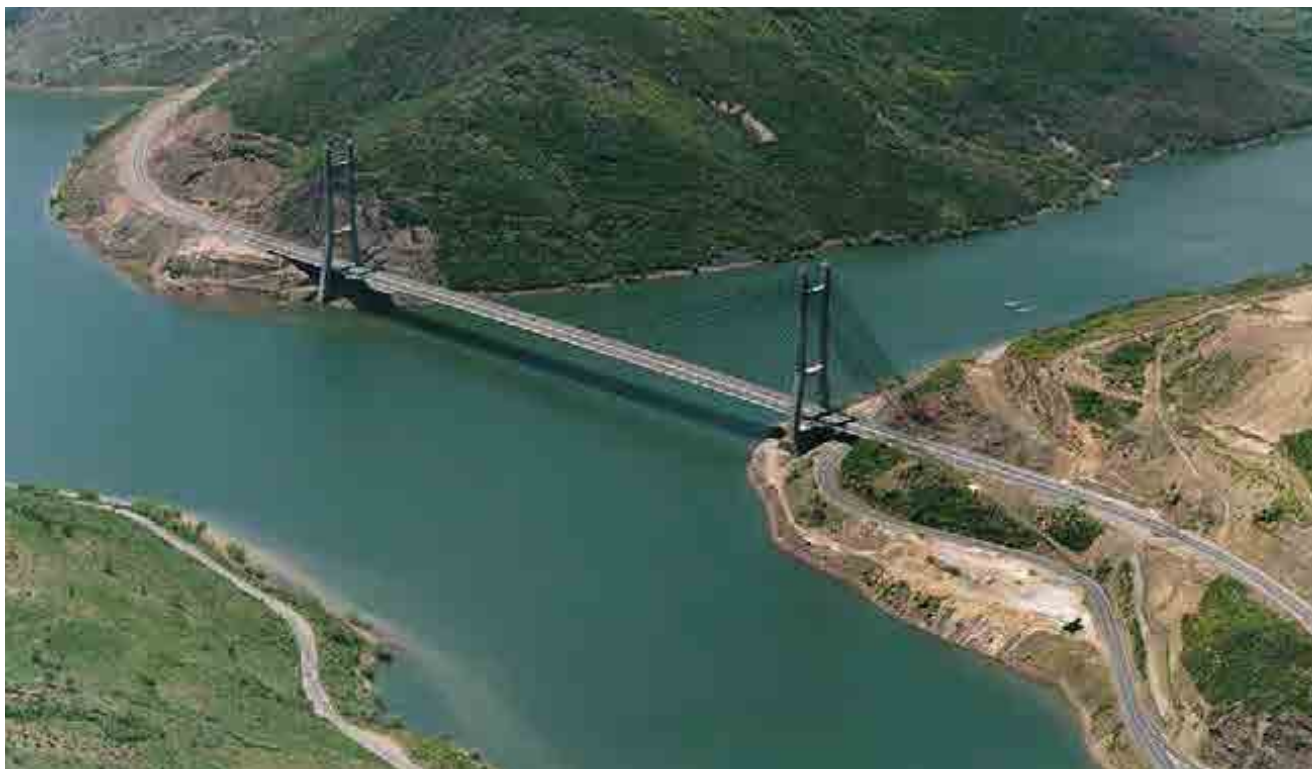
^ Puente Fernández Casado. Autopista León-Campomanes. España. Fernández Casado Bridge. León-Campomanes Toll Road. Spain.
