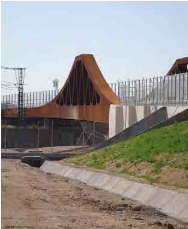
^ LAV Madrid (Estación de Atocha). Torrejón de Velasco. Plataforma para la ampliación de dos a cuatro vías. España. HSR line Madrid (Atocha Station). Torrejón de Velasco. Platform for the expansion from two to four lanes. Spain.
