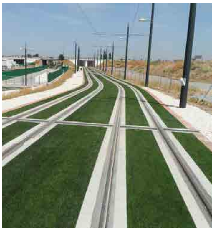
^ Metro Ligero de Granada. Línea 1. Tramo 1. Subtramo Macarena-Estadio Juventud. España. Granada Light Railway. Line 1. Section 1. Macarena-Estadio Juventud subsection. Spain.
