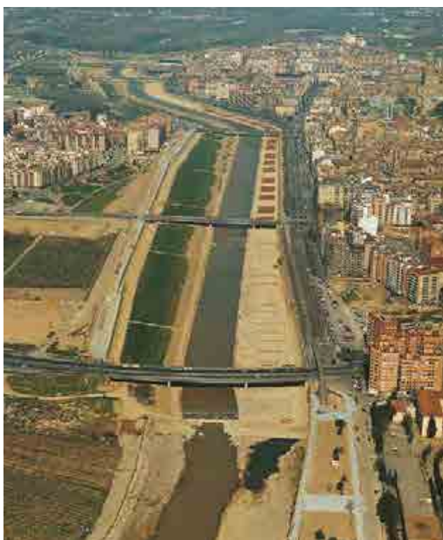
^ Río Segre. Encauzamiento. España. Segre River. Channeling. Spain.
