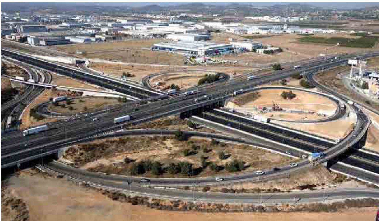
^ Ampliación a un tercer carril de la Autovía A-3. Tramo Buñol-Valencia. España. Enlargement to a third lane of the of the A-3 Expressway. Buñol-Valencia section. Spain.
