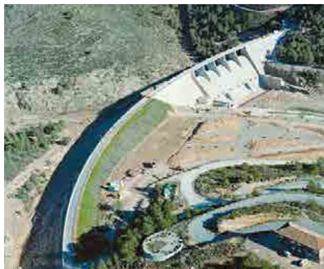
^ Presa del Algar. España. Algar Dam. Spain.
