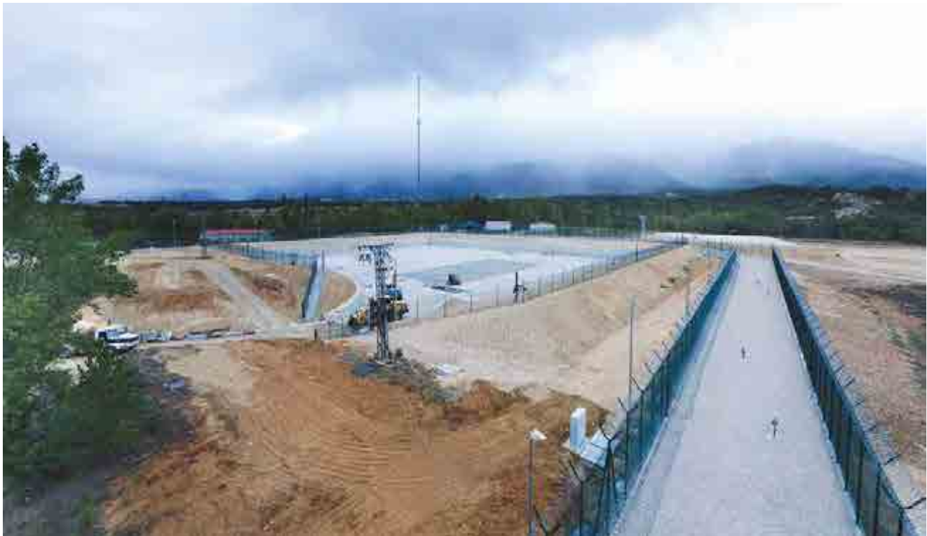
^ Almacén Temporal Individualizado de residuos de la Central Nuclear de Santa María de Garoña, Burgos, España. Temporary individualized waste warehouse in Santa María de Garoña nuclear power plant, Burgos, Spain.
