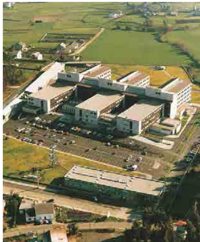
^ Hospital de la Marina. Ferrol. España. La Marina Hospital. Ferrol. Spain.
