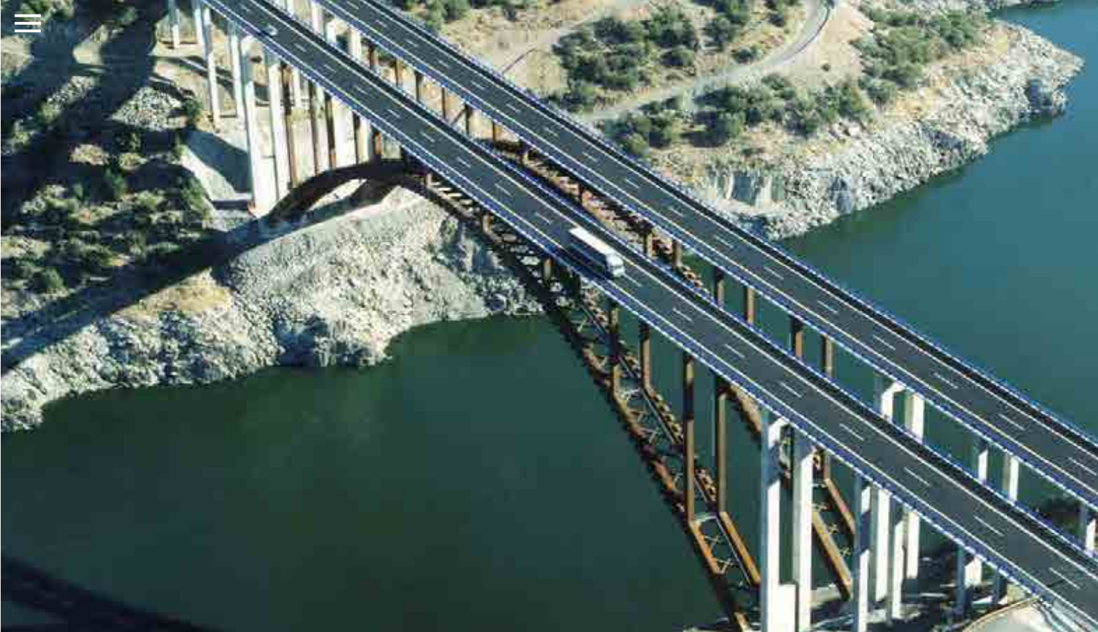
^ Autovía de la Plata A-66. Tramo Hinojal-Cañaveral. España. A-66 La Plata Expressway. Hinojal-Cañaveral section. Spain.
