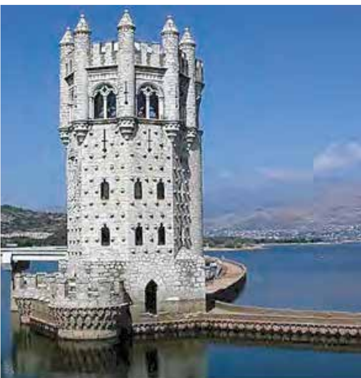
^ Presa de Santillana. España. Santillana Dam. Spain.
