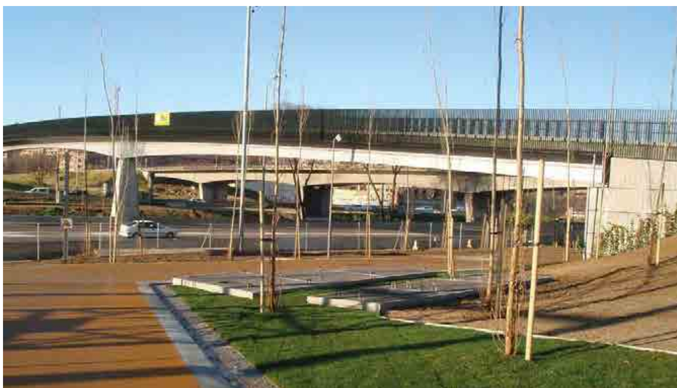
^ Pasarela Peatonal y Ciclista. Legazpi-Avenida Manzanares. España. Pedestrian and Cyclist Footbridge. Legazpi-Manzanares Avenue. Spain.
