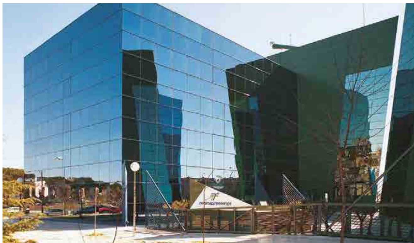
^ Edificio de oficinas. Trasmediterránea. Madrid. España. Office building. Trasmediterránea. Madrid. Spain.
