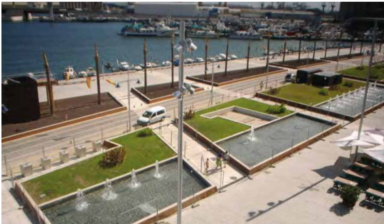
^ Urbanización El Serrallo. Granada. España. El Serrallo urban development. Granada. Spain.
