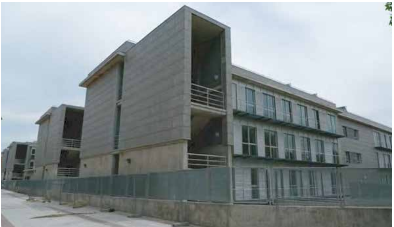
^ Residencia de la Tercera Edad. Madrid. España. Construction of a Residence for the Elderly. Madrid. Spain.
