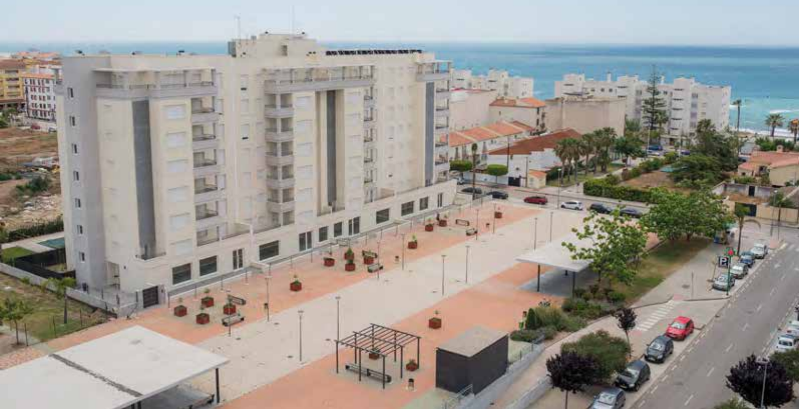
^ 60 viviendas. Málaga. España. 60 housing units. Málaga. Spain.
