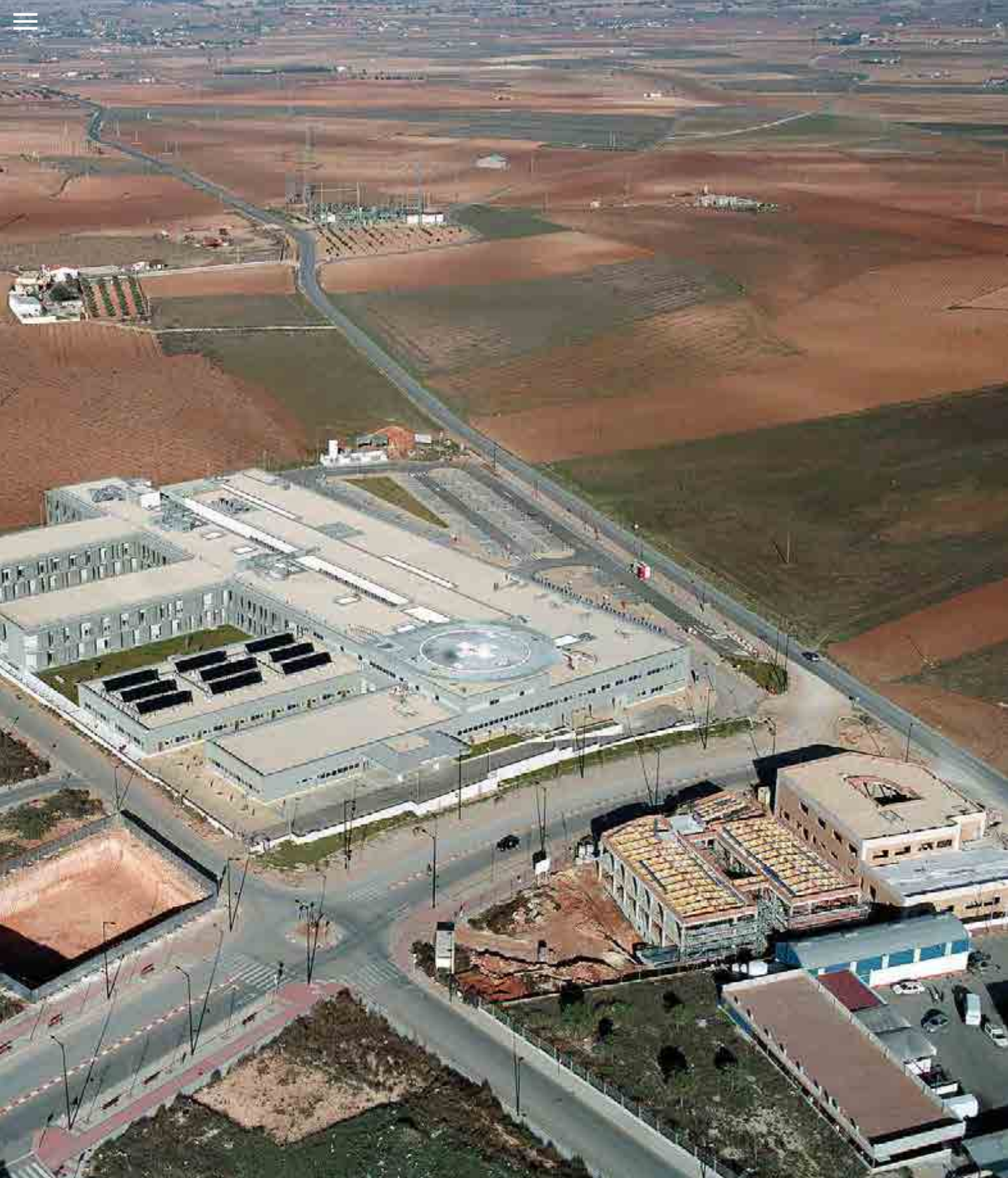
^ Hospital General de Villarrobledo. España. Villarrobledo General Hospital. Spain.
