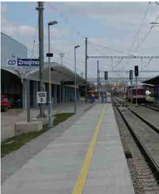
^ Línea ferroviaria. Tramo Peú Satov-Znojmo. Electrificación. República Checa. Railway line. Peú Satov-Znojmo section. Electrification. Czech Republic.
