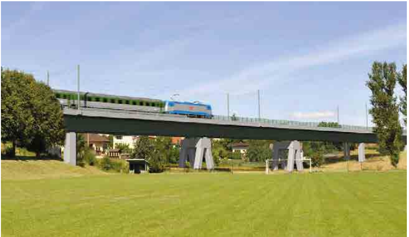
^ Línea ferroviaria Tábor-Sudoměřice. Modernización. República Checa. Tabor-Sudoměřice-Votice railway line. Modernization. Czech Republic.
