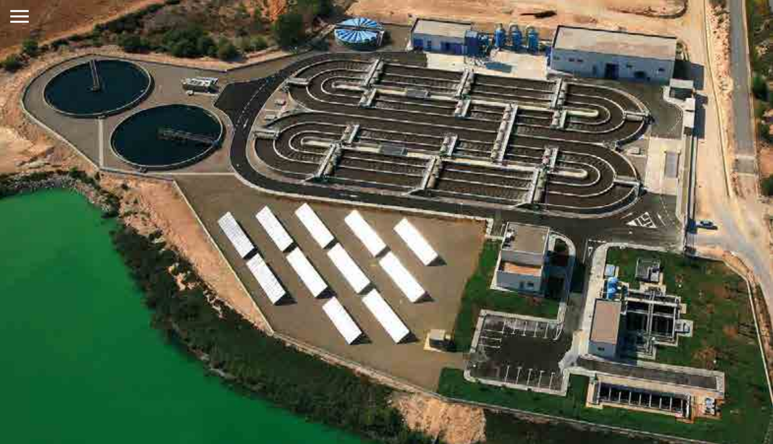
^ EDAR de Pilar de la Horadada. España. Pilar de la Horadada WWTP. Spain.
