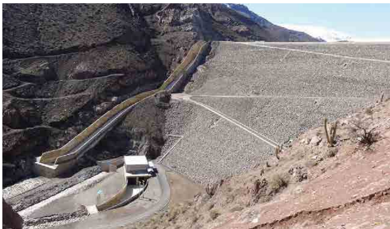
^ Embalse Chacillas. Chile. Chacillas Reservoir. Chile.
