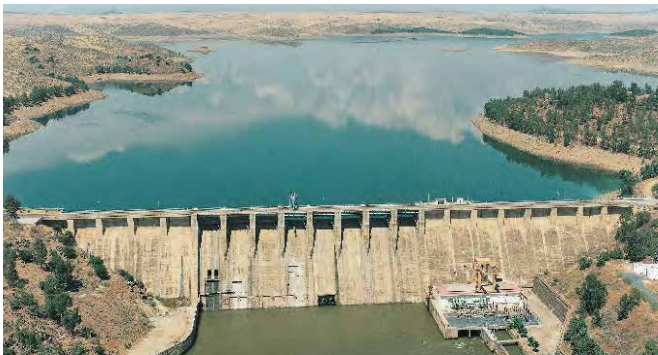
^ Presa de Zújar. España. Zújar Dam. Spain.
