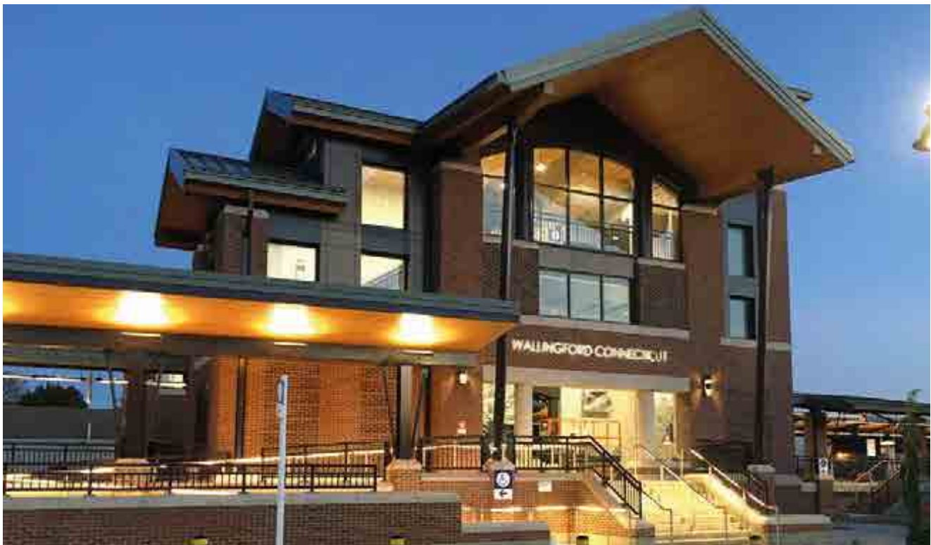
^ Rehabilitación y mejora de tres estaciones para Amtrak. Estados Unidos. Rehabilitation and upgrade of three stations for Amtrak. United States.
