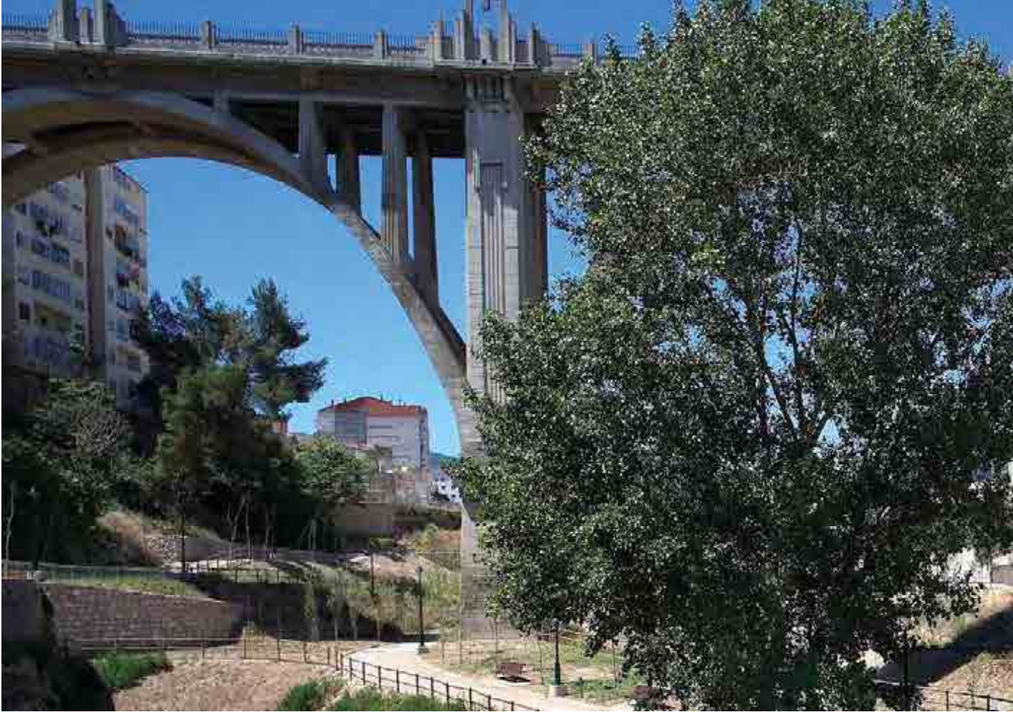
^ Río Barxell. Encauzamiento. España. Barxell River. Channeling. Spain.
