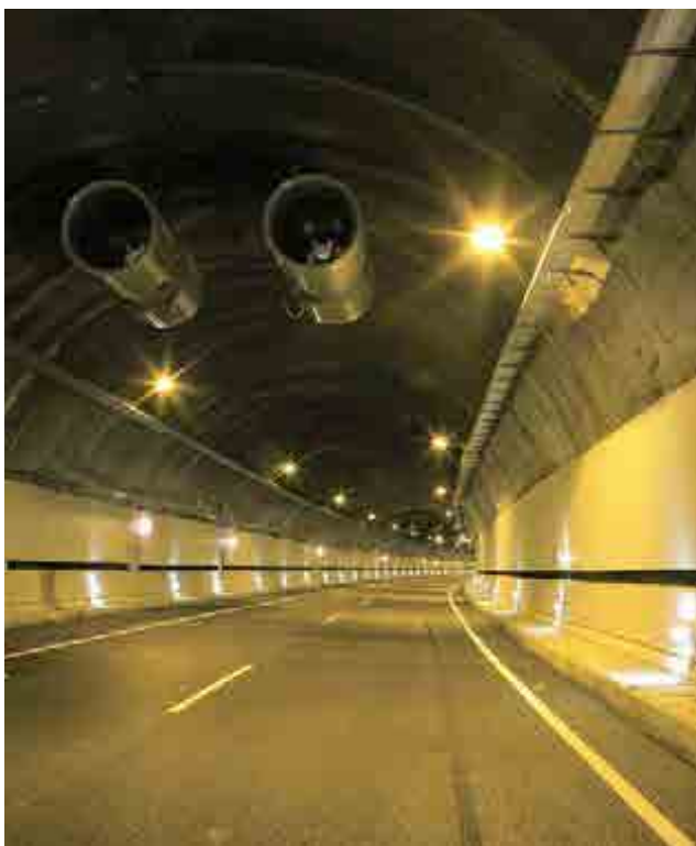
^ Túnel del Eje Aeropuerto Madrid-Barajas. España. Madrid-Barajas Airport axis Tunnel. Spain.
