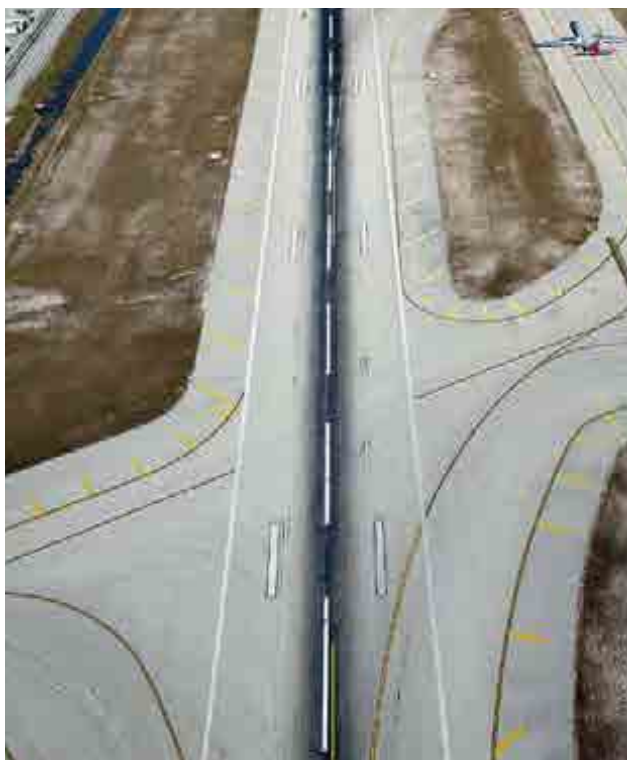
^ Aeropuerto Internacional de Miami. Rehabilitación del pavimento de la pista 12/30. Estados Unidos. Miami International Airport. Improvement of pavement on the runway 12/30. United States.
