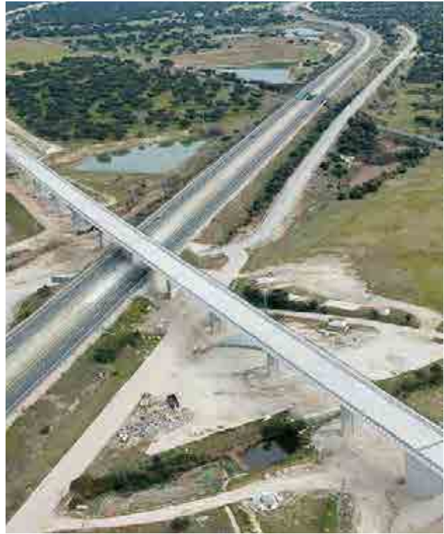
^ LAV Madrid-Extremadura-Talayuela-Cáceres. Tramo Navalmoral de La Mata-Casatejada. Plataforma. España. Madrid-Extremadura-Talayuela-Cáceres HSR line. Navalmoral de La Mata-Casatejada section. Spain.
