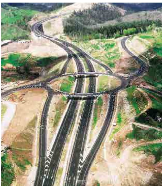
^ Autovía del Cantábrico A-8. Tramo Cabezón de la Sal-Lamadrid. España. A-8 Cantabrian Expressway. Cabezón de la Sal-Lamadrid section. Spain.
