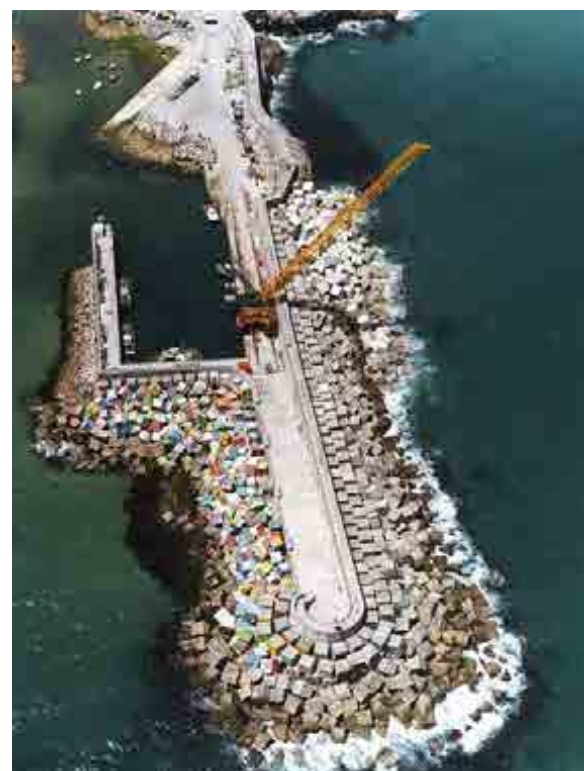
^ Puerto de Llanes. Recarga de bloques. España. Port of Llanes. Reloading of blocks. Spain.
