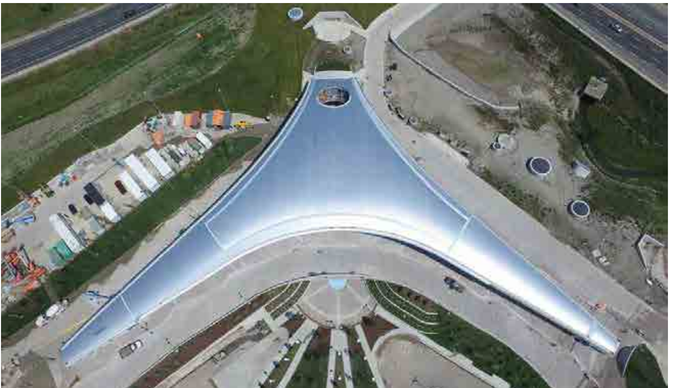
^ Estación de Metro York-Spadina. Ampliación. Canadá. York-Spadina Metro Station. Expansion. Canada.
