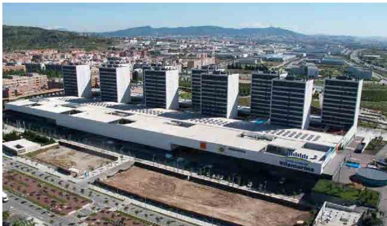
^ Residencial de viviendas y centro comercial Vilamarina. Viladecans. España. Vilamarina residential housing complex and shopping center. Viladecans. Spain.
