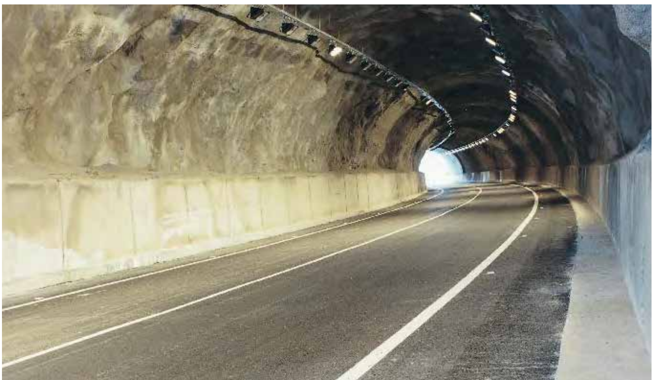
^ Túnel. Carretera Xesta y Benifallet. España. Tunnel. Xesta and Benifallet Road. Spain.
