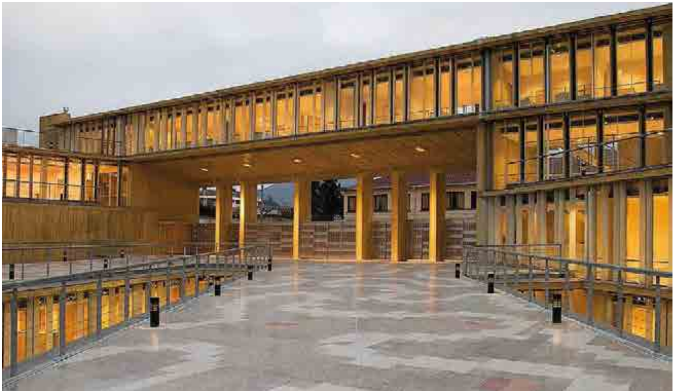
^ Edificio del Ministerio de Obras Públicas. La Serena IV Región. Chile. Building of the Ministry of Public Works. The Serena IV Region. Chile.
