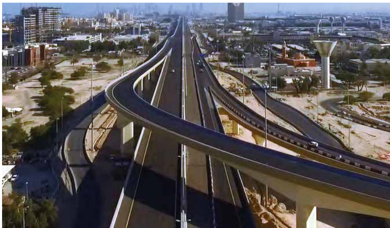
^ Viaducto urbano Jamal Abdul Nasser. Kuwait. Jamal Abdul Nasser Urban Viaduct. Kuwait.
