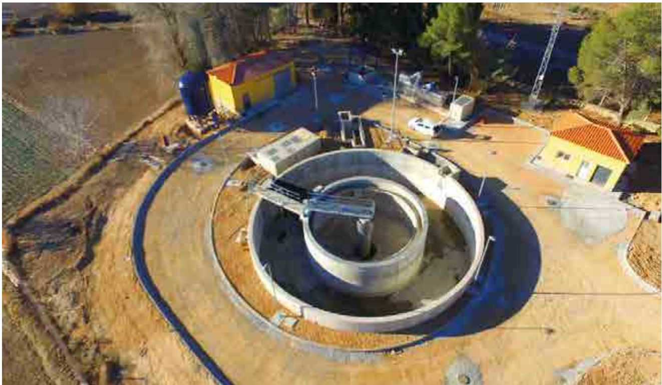
^ EDAR de Lezuza. España. Lezuza WWTP. Spain.
