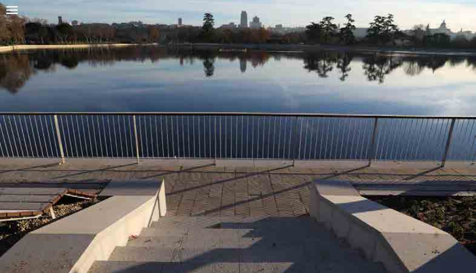
^ Casa de Campo. Restauración del muro del lago. Madrid. España. Casa de Campo. Restoration of the lake wall. Madrid. Spain.
