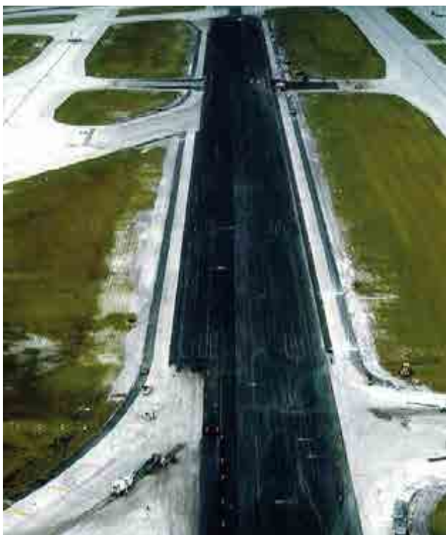
^ Aeropuerto Fort Lauderdale. Construcción de la pista 9L-27R. Los Angeles. Estados Unidos. Fort Lauderdale Airport. Construction of 9L-27R runway. Los Angeles. United States.
