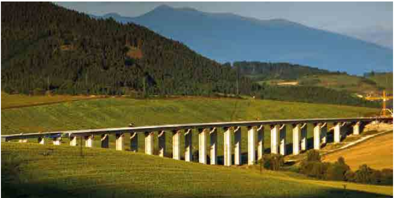
^ Autopista D1. Tramo Hubová-Ivachnová. Eslovaquia. D1 Toll Road. Hubová-Ivachnová section. Slovakia.
