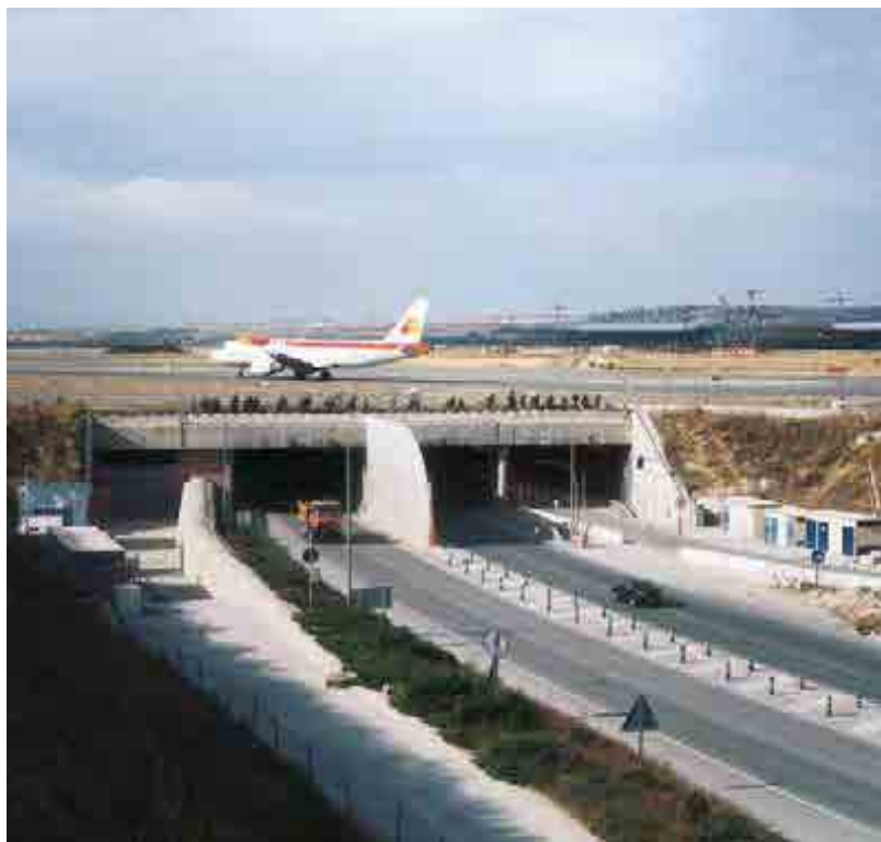
^ Túneles de la carretera M-11. Madrid-Barajas. España. Tunnels on the M-11. Madrid-Barajas. Spain.
