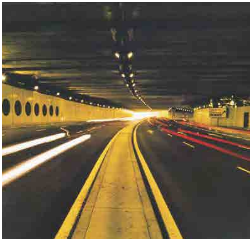
^ Túnel de la Plaza de Castilla. Madrid. España. Plaza de Castilla Tunnel. Madrid. Spain.
