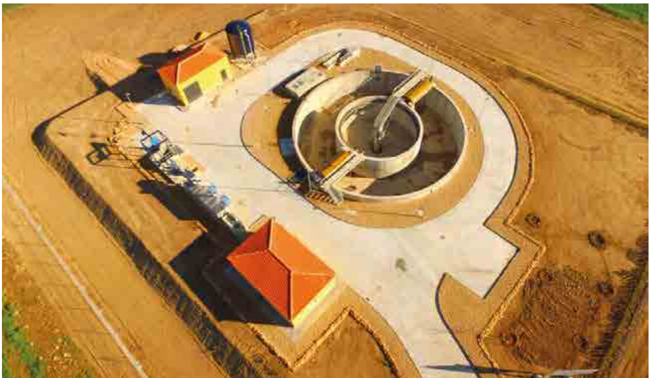
^ EDAR de Balazote. España. Balazote WWTP. Spain.
