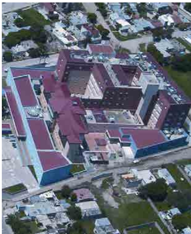
^ Hospital de Río Cuarto. Córdoba. Argentina. Río Cuarto Hospital. Córdoba. Argentina.
