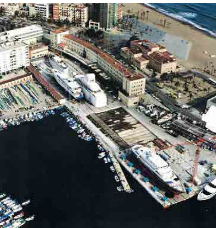
^ Puerto de Barcelona. Muelle Syncrolift. España. Port of Barcelona. Syncrolift dock. Spain.
