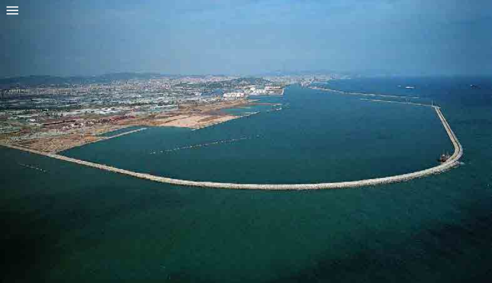
^ Puerto de Barcelona. Ampliación del Dique Sur. España. Port of Barcelona. Enlargement of the South Breakwater. Spain.
