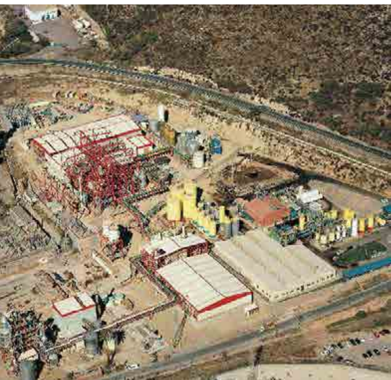
^ Planta de carbonato de estroncio. Murcia. España. Strontium carbonate plant. Murcia. Spain.
