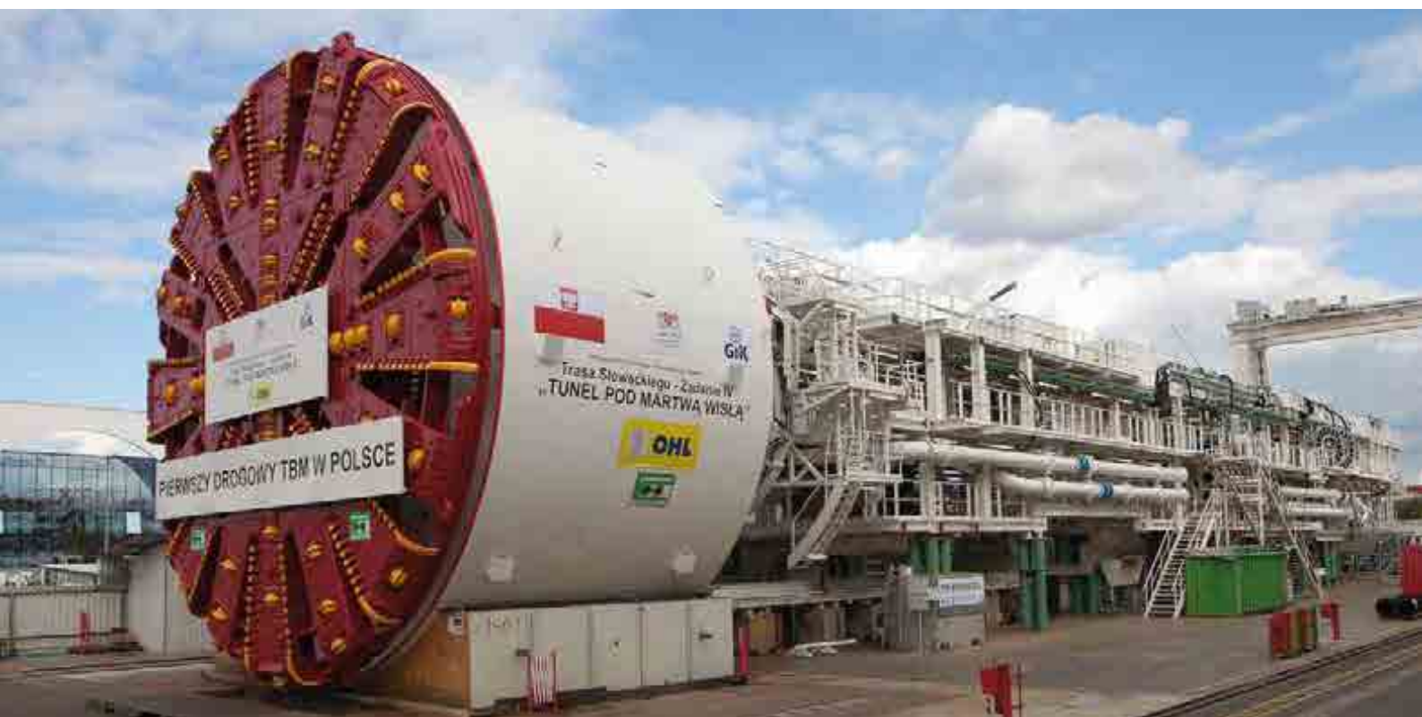
^ Tuneladora hidroescudo. Gdansk. Polonia. Tunnel boring machine. Gdansk. Poland.
