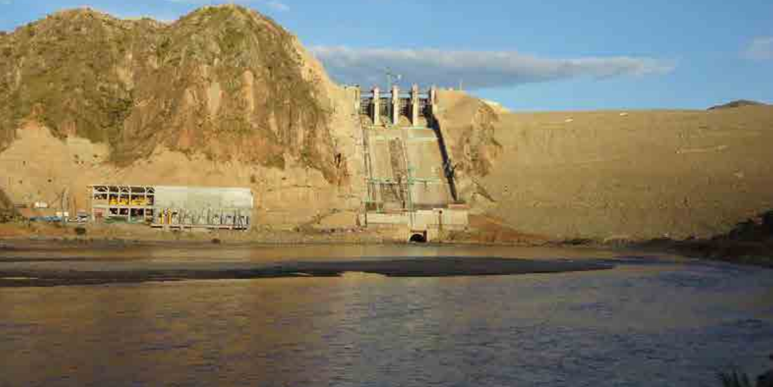
^ Presa El Quimbo. Proyecto hidroeléctrico. Colombia. El Quimbo Dam. Hydroelectric project. Colombia.
