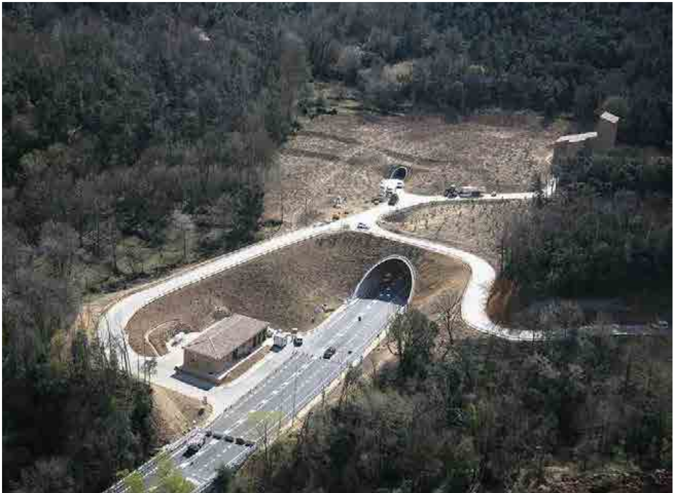
^ Túnel de Bracons. Carretera C-37 Vic-Olot. Tramo Torelló-La Vall d'en Bas. España. Bracons Tunnel. C-37 Vic-Olot Road. Torelló-La Vall d'en Bas section. Spain.
