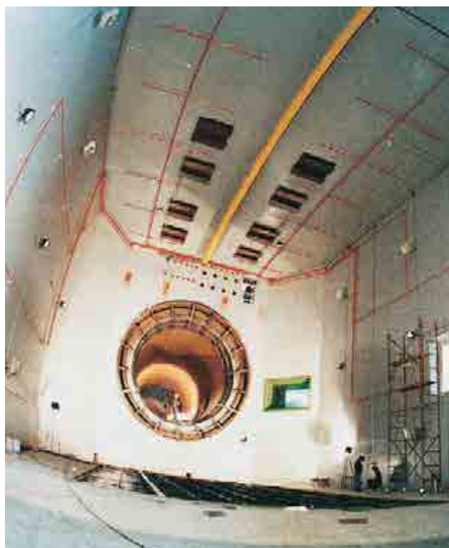
^ Banco de pruebas para turborreactores del INTA. Madrid. España. Test bench for turbojet engines of the INTA. Madrid. Spain.
