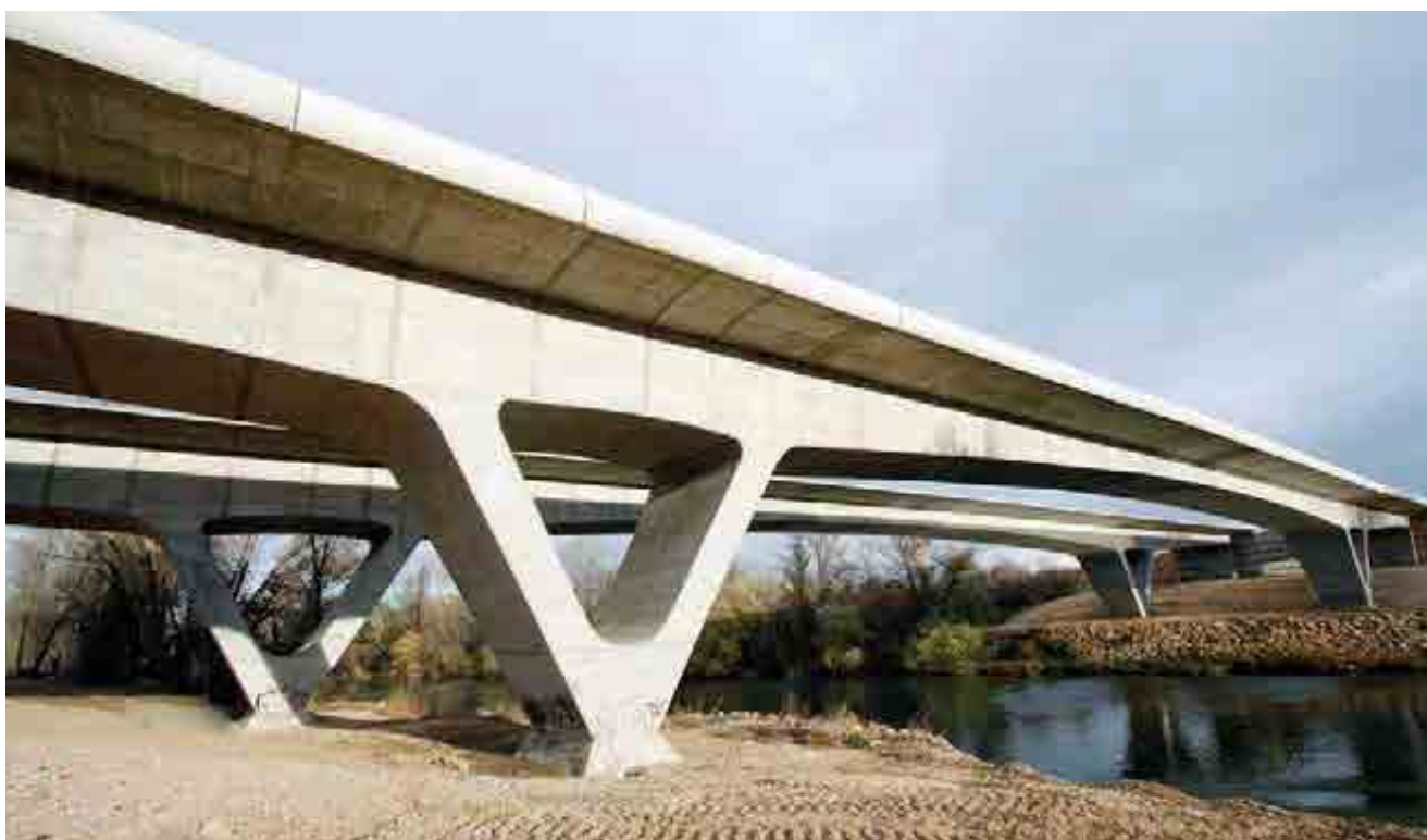
^ Puente sobre el río Pisuerga. Ronda exterior sur. España. Bridge over the Pisuerga River. Southern outer Ring Road. Spain.
