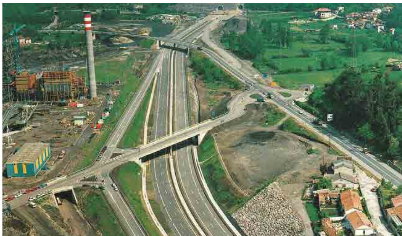
^ Autovía de la Plata A-66. Tramo Baiña-Mieres. España. A-66 La Plata Expressway. Baiña-Mieres section. Spain.
