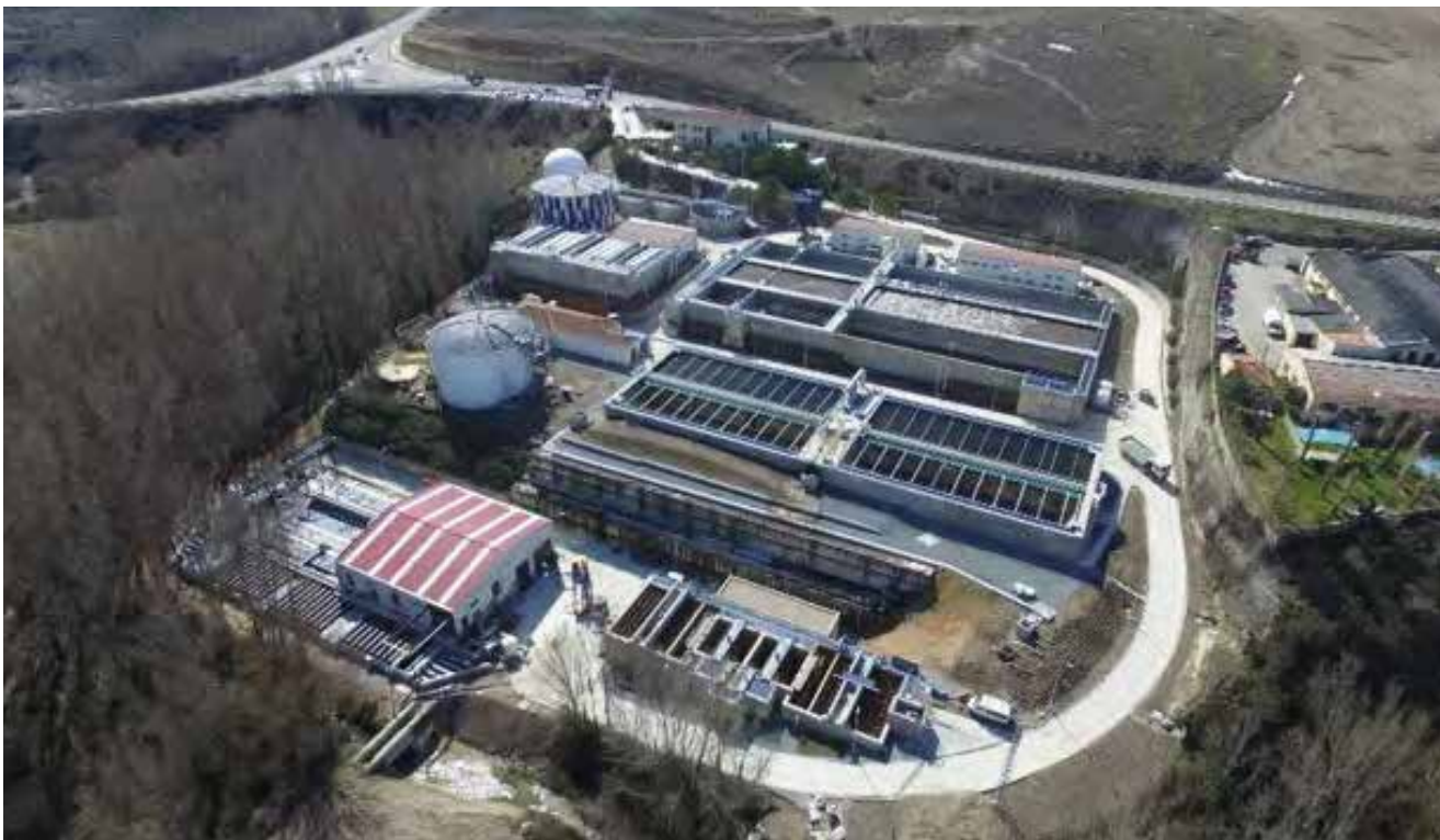
^ EDAR de Segovia. España. Segovia WWTP. Spain.
