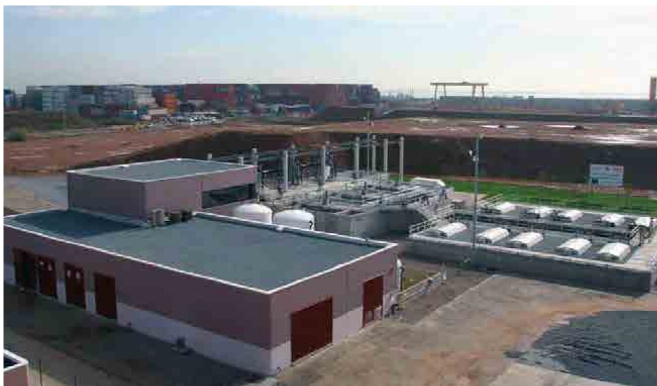
^ EDAR de Baix Llobregat. España. Baix Llobregat WWTP. Spain.
