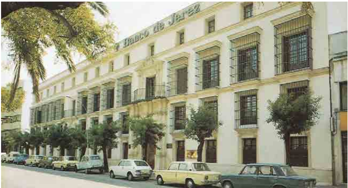
^ Sede central del Banco de Jerez (Hotel Trip Jerez, en la actualidad). Jerez. España. Banco de Jerez headquarters (Trip Jerez Hotel, today). Jerez. Spain.
