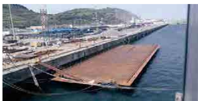
^ SATO Esparteña. Pontona. España. SATO Esparteña. Pontoon. Spain.
