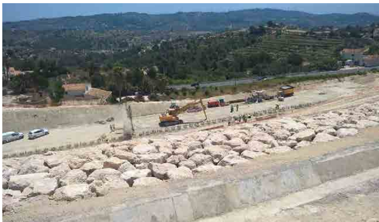
^ Carretera N-332. Tramo variante de Benissa. España. N-332 Road. Benissa Bypass section. Spain.
