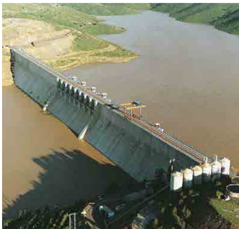
^ Presa de la Serena. España. La Serena Dam. Spain.
