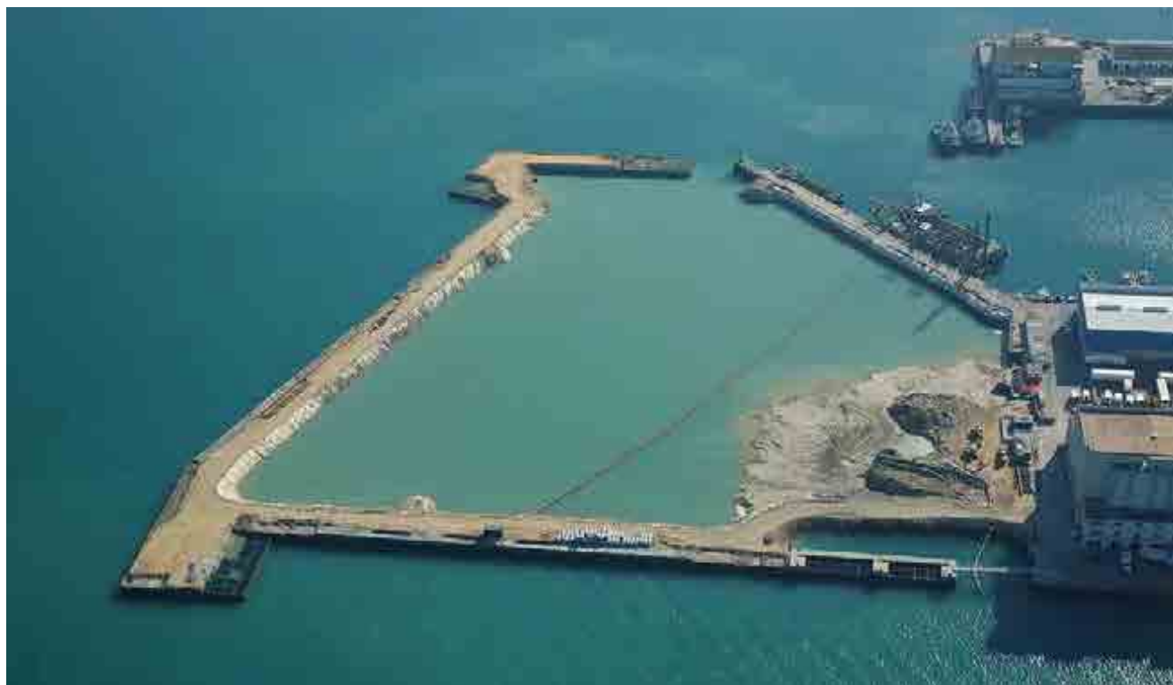
^ Puerto de Cádiz. Ampliación del muelle Marqués de Comillas. España. Port of Cádiz. Enlargement of the Marqués de Comillas Quay. Spain.
