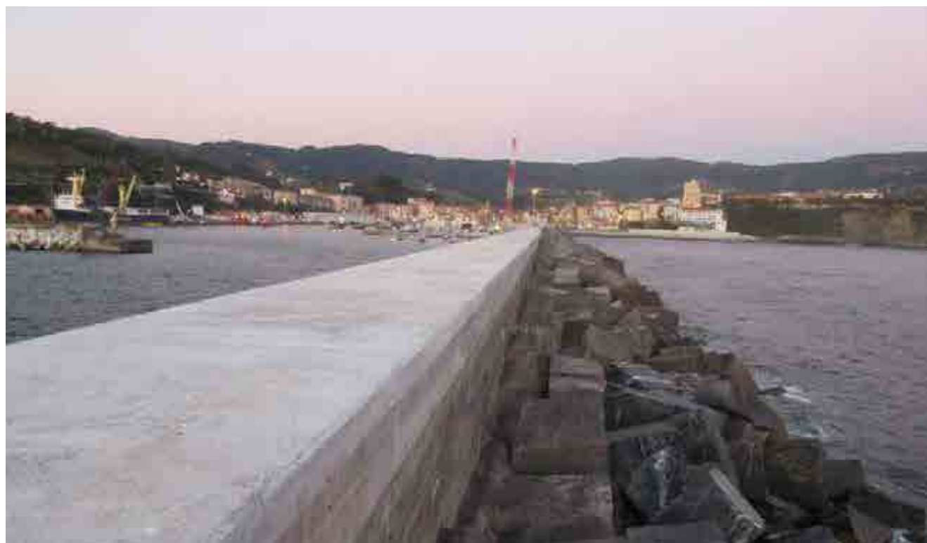
^ Puerto de Bermeo. Reparación del espaldón del dique de abrigo. España. Port of Bermeo. Repair of the shelter wall of the breakwater. Spain.
