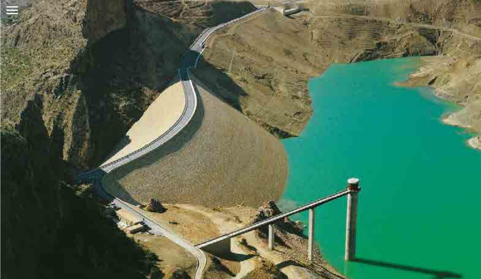
^ Presa del Portillo. España. Portillo Dam. Spain.
