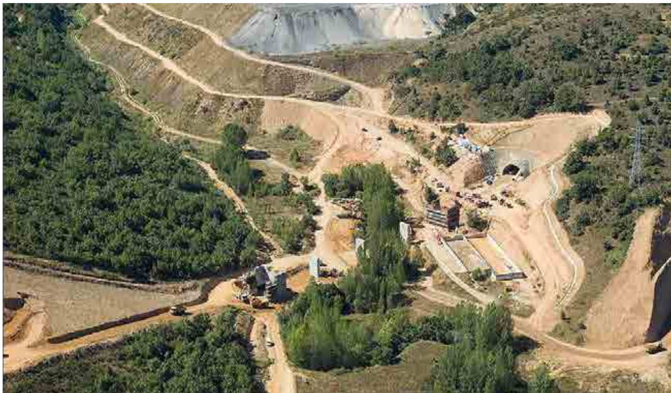
^ LAV León-Asturias. Variante de Pajares. Tramo La Robla-Túneles de Pajares. España. HSR León-Asturias. Pajares Bypass. La Robla-Pajares Tunnels section. Spain.
