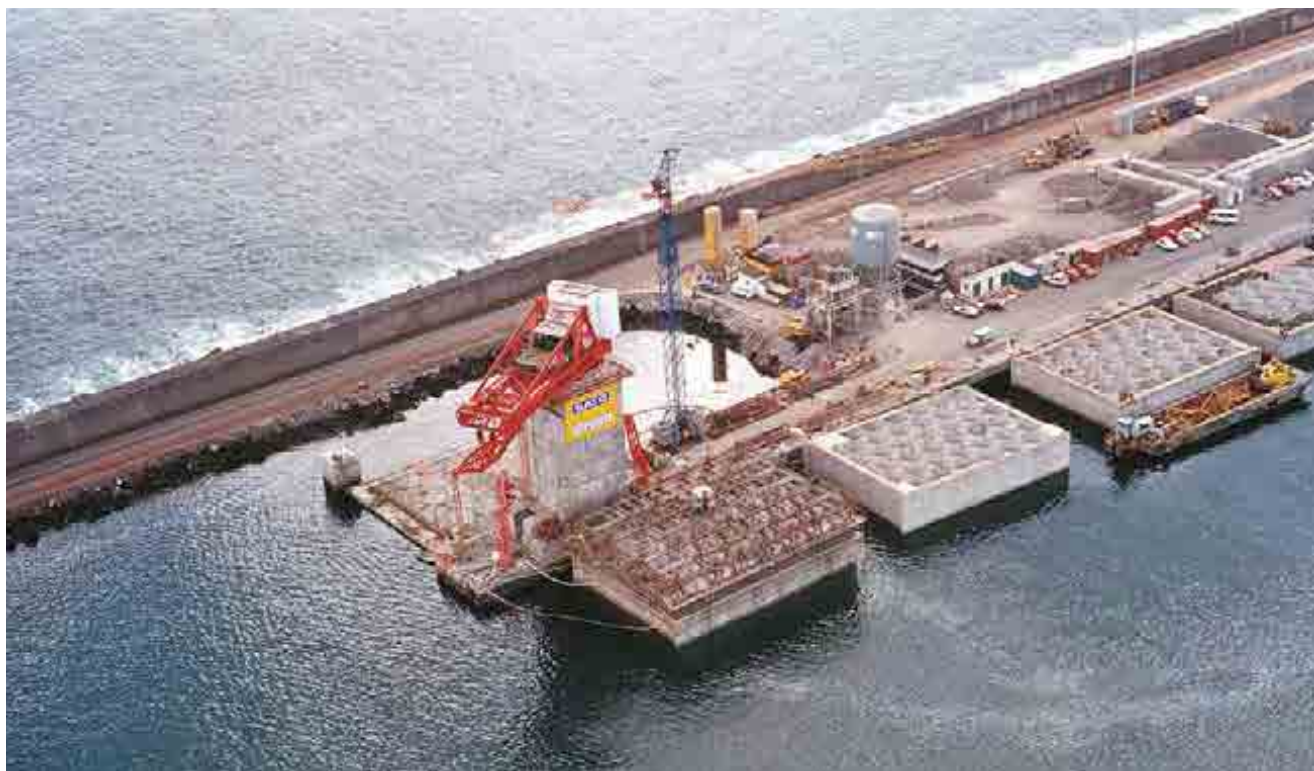
^ Puerto de las Palmas de Gran Canaria. Dique Reina Sofía. España Port of Las Palmas de Gran Canaria. Reina Sofía Quay. Spain.
