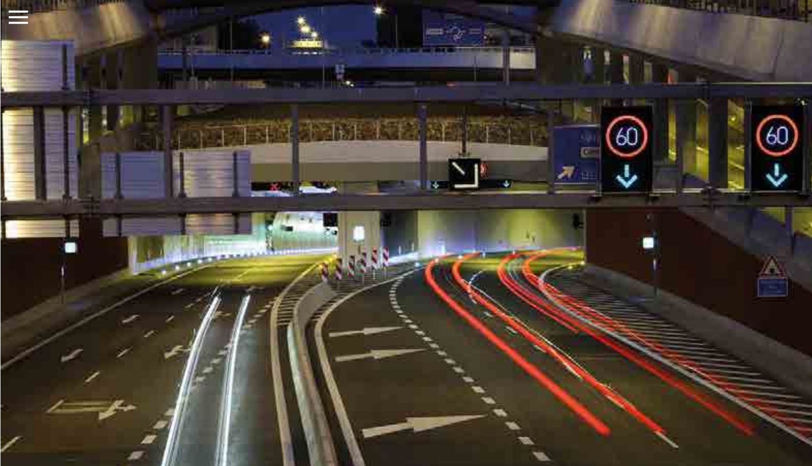
^ Túneles Kralovo Pole. Brno. República Checa. Kralovo Pole Tunnels. Brno. Czech Republic.
