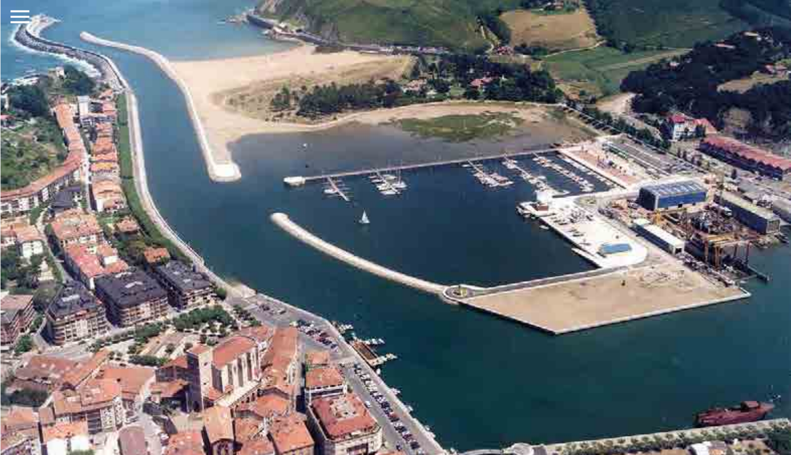
^ Puerto de Zumaia. España. Port of Zumaia. Spain.
