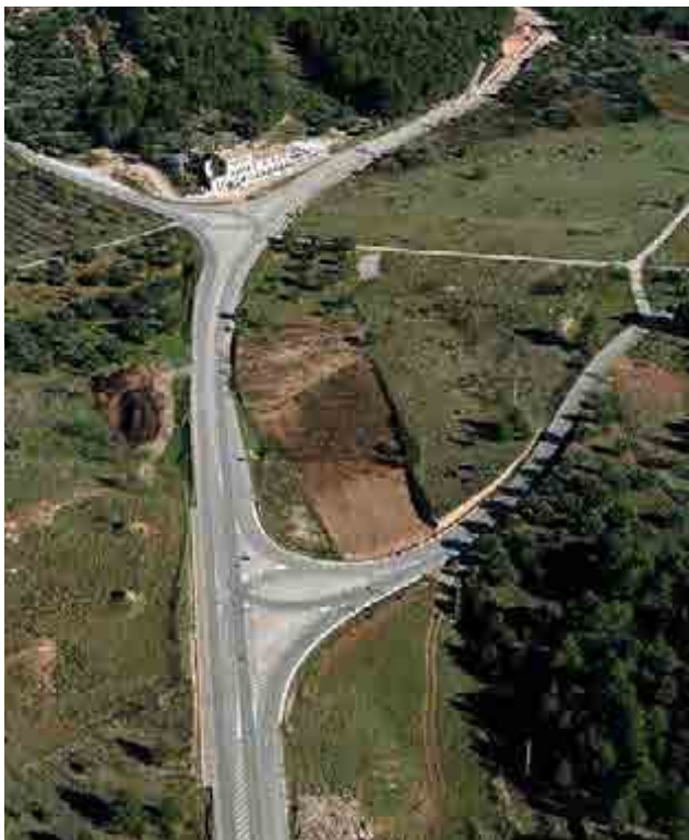
^ Carretera C-12. Tramo Horta de Sant Joan-Xerta. Acondicionamiento. España. C-12 Road. Horta de Sant Joan-Xerta section. Conditioning. Spain.
