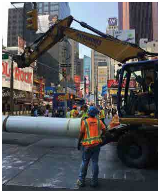
^ MED 609. Instalación de red de abastecimiento de agua. Estados Unidos. MED 609. Water supply network installation. United States.
