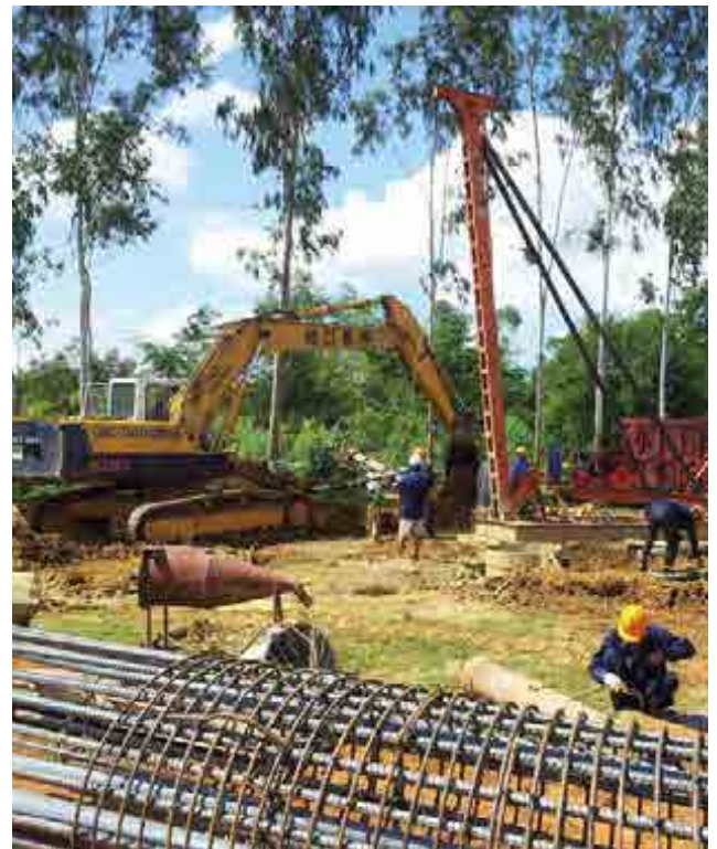
^ Autopista en Da Nang. Vietnam. Da Nang Toll Road. Vietnam.
