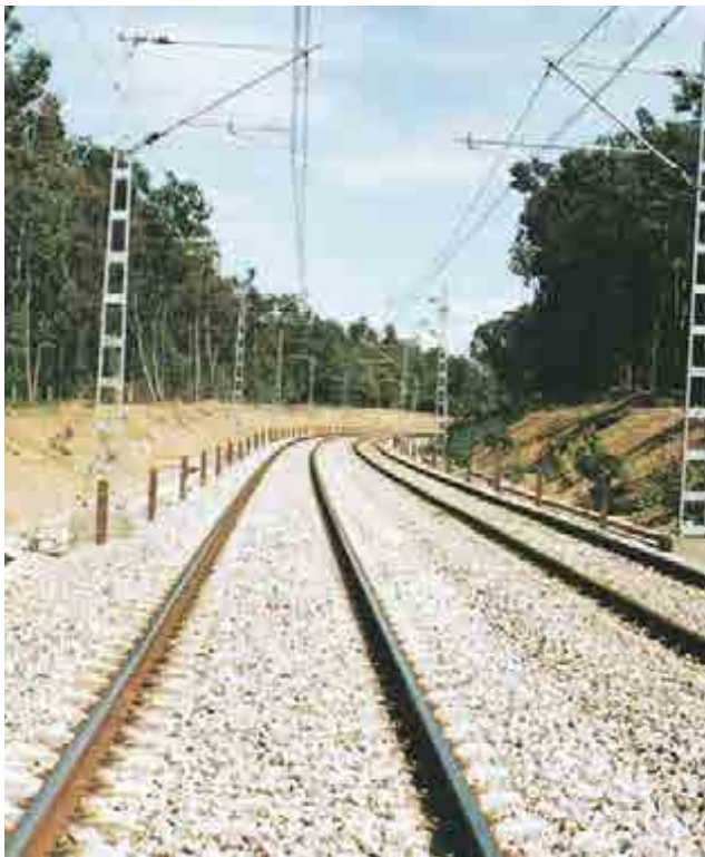
^ Renovación de vía ferroviaria. Marruecos. Renovation of railway track. Morocco.
