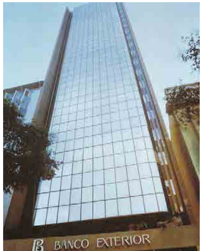
^ Banco Exterior de España. Santiago de Chile. Chile. Banco Exterior de España. Santiago de Chile. Chile.
