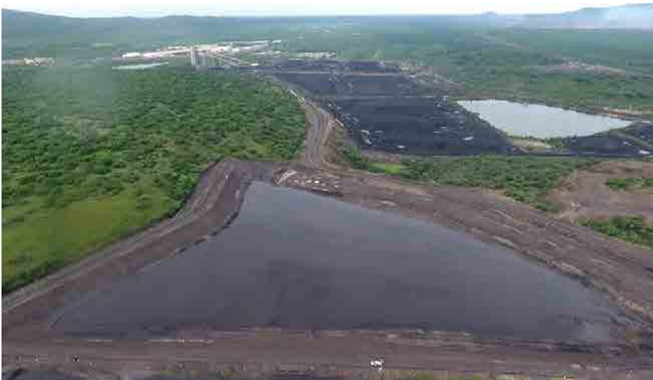
Proyecto minero Cerrejón. Construcción de la presa y depósito de relaves Cantor Norte. Colombia. Cerrejón mining project. Construction of the Cantor Norte dam and tailings pond. Colombia.
