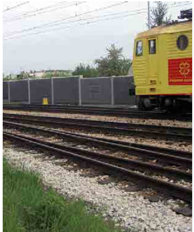
^ Línea ferroviaria. Tramo Kuřim-Tišnov. Mejora de la vía. República Checa. Railway line. Kuřim-Tišnov section. Improvement of the track. Czech Republic.
