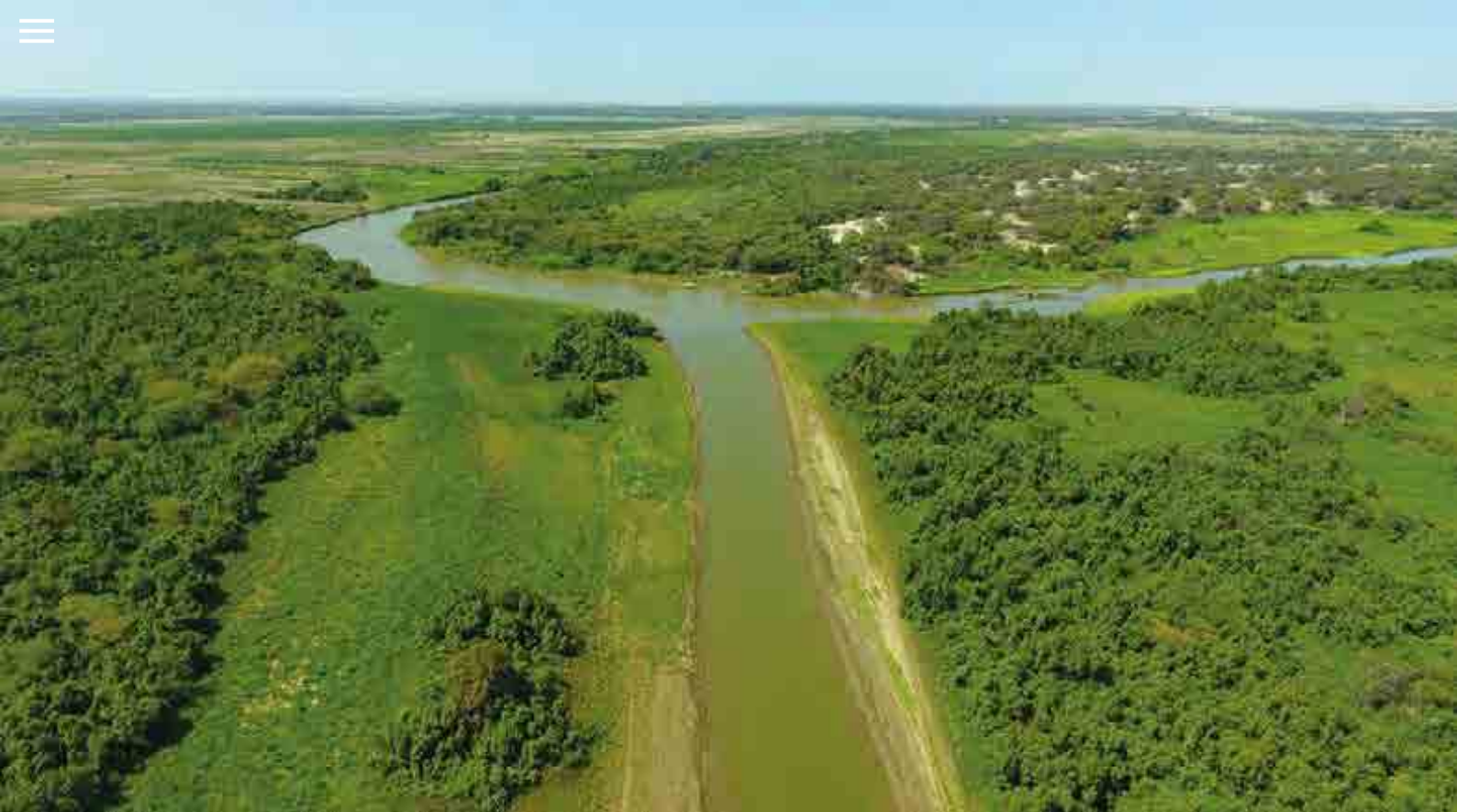
^ Río Piura. Tramo 2. Descolmatación. Perú. Piura River. Section 2. Clearing. Peru.
