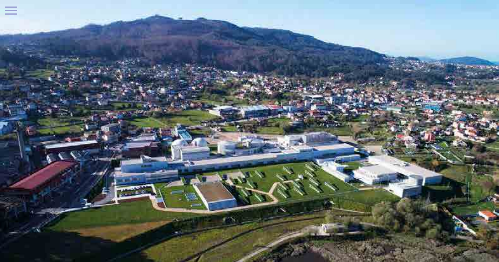
^ EDAR de Lagares. España. Lagares WWTP. Spain.
