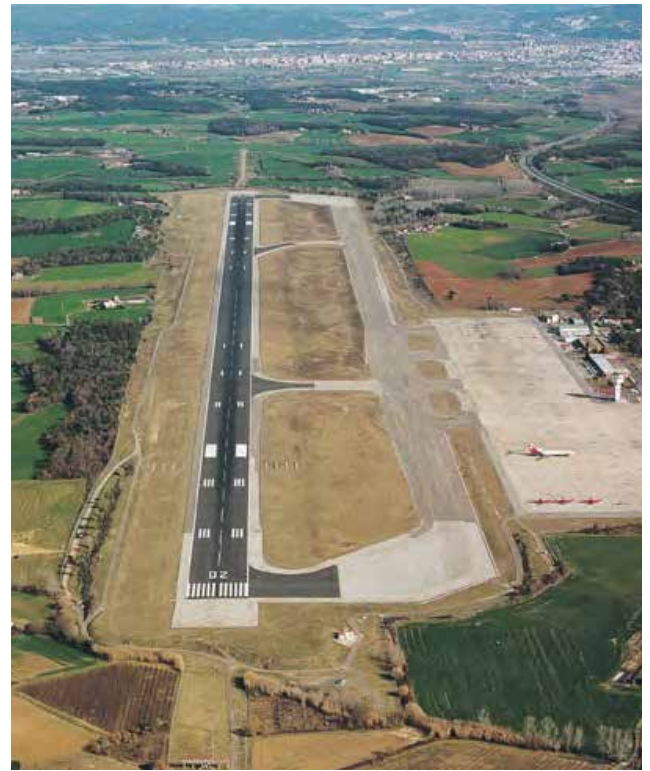
^ Aeropuerto de Girona-Costa Brava. Pista. España. Girona-Costa Brava Airport. Runway. Spain.
