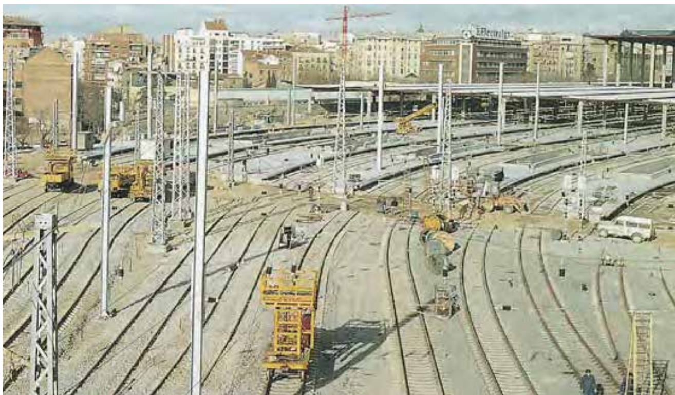
^ Estación ferroviaria de Atocha. Instalación de catenarias para la LAV. Madrid. España. Atocha Railway Station. Installation of catenaries for the high-speed line. Madrid. Spain.
