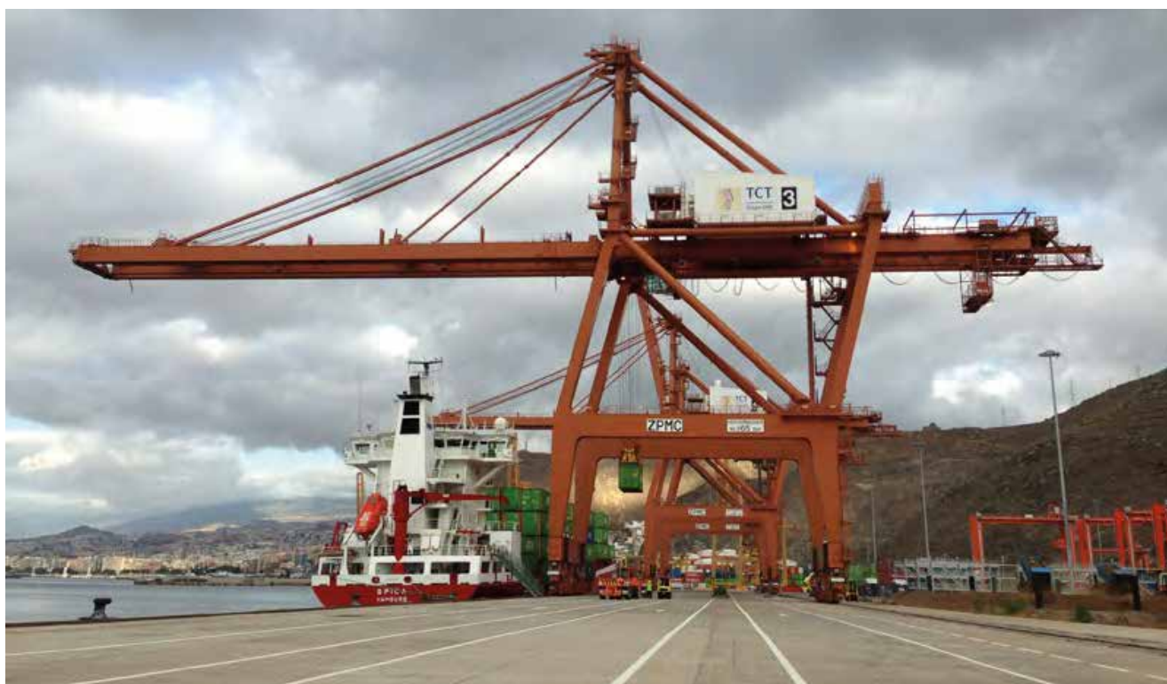
^ Puerto de Santa Cruz de Tenerife. Terminal de contenedores del Dique del Este. España. Port of Santa Cruz de Tenerife. Container terminal of East Breakwater. Spain.
