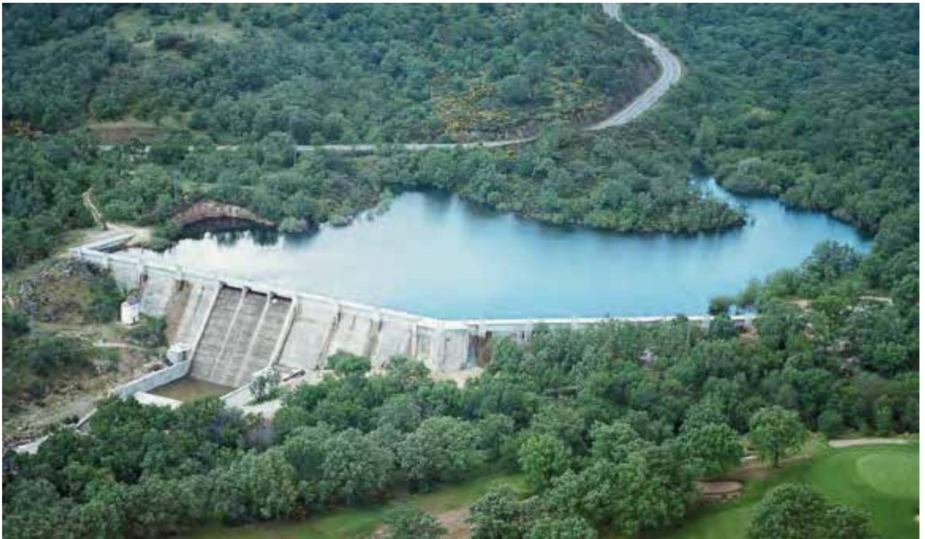
^ Presa de El Batán. Remodelación. España. El Batán Dam. Remodeling. Spain.
