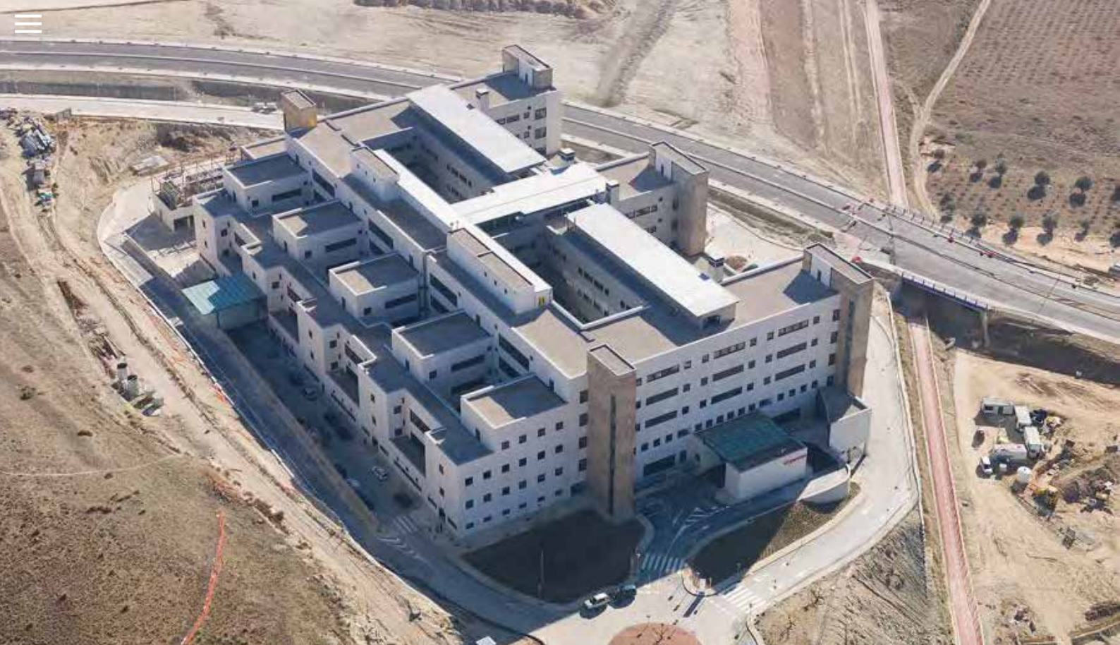
^ Hospital Universitario del Sureste. Arganda del Rey. España. Southeast University Hospital. Arganda del Rey. Spain.
