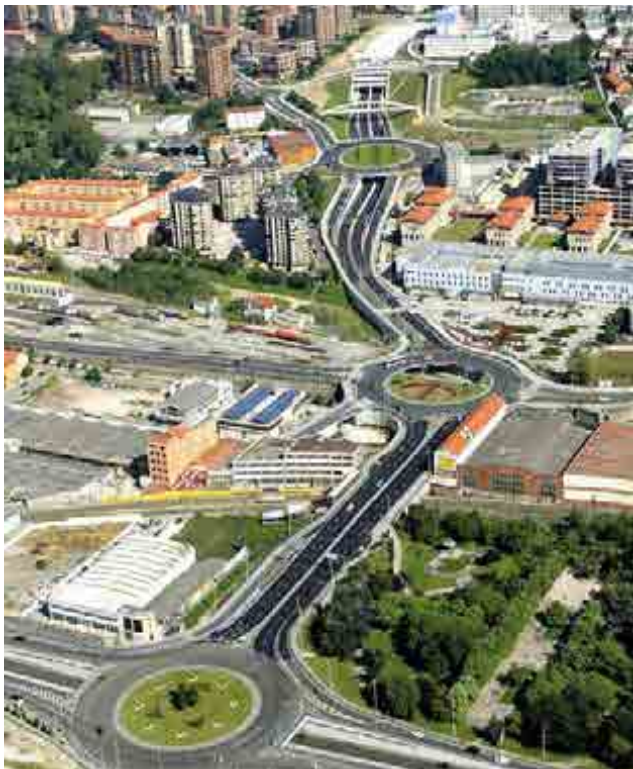
^ Autovía S-20. Distribuidor La Marga-La Albericia. Tramo CN-611. España S-20 Expressway. La Marga-La Albericia distributor. Section CN-611. Spain.
