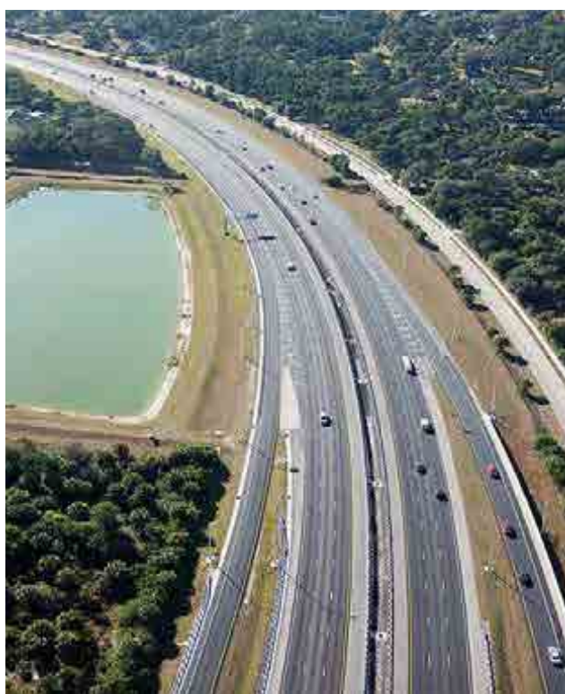
^ Renovación de un tramo de la carretera Interstate-95. Florida. Estados Unidos. Renovation of a section of Interstate-95. Florida. United States.
