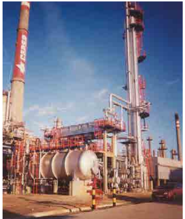
^ Stripper de aguas ácidas. Huelva. España. Sour-water stripper. Huelva. Spain.
