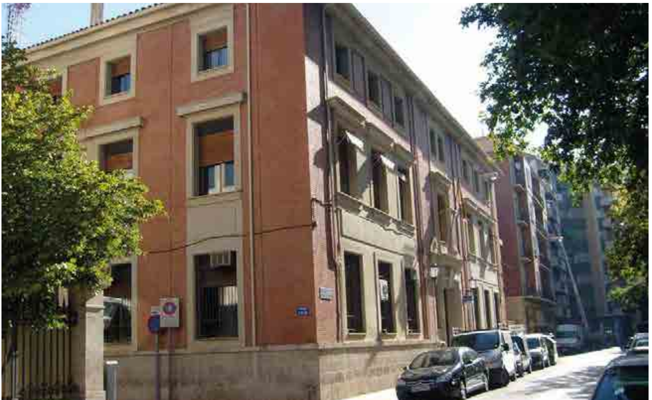
^ Edificio Correos. Reforma. Cuenca. España. Correos building. Renovation. Cuenca. Spain.
