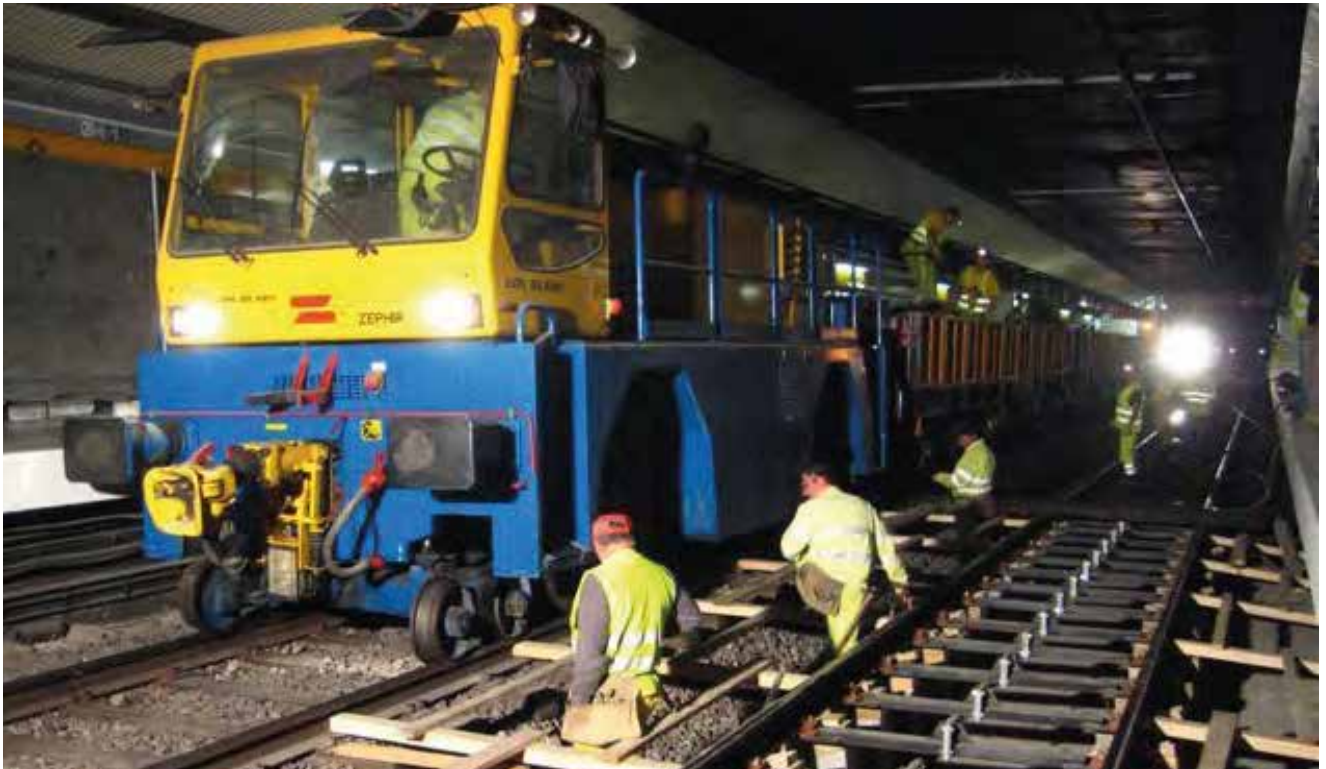
^ Metro de Barcelona. Línea 4. Tramo Bogatel-Selva del Mar. España. Metro de Barcelona. Line 4. Bogatel-Selva del Mar section. Spain.
