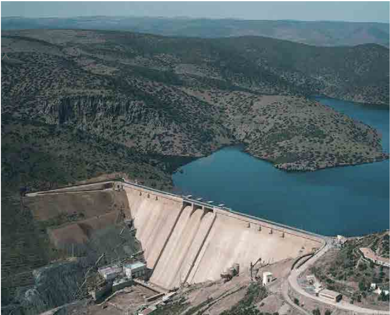
^ Presa de Guadalmena. España. Guadalmena Dam. Spain.
