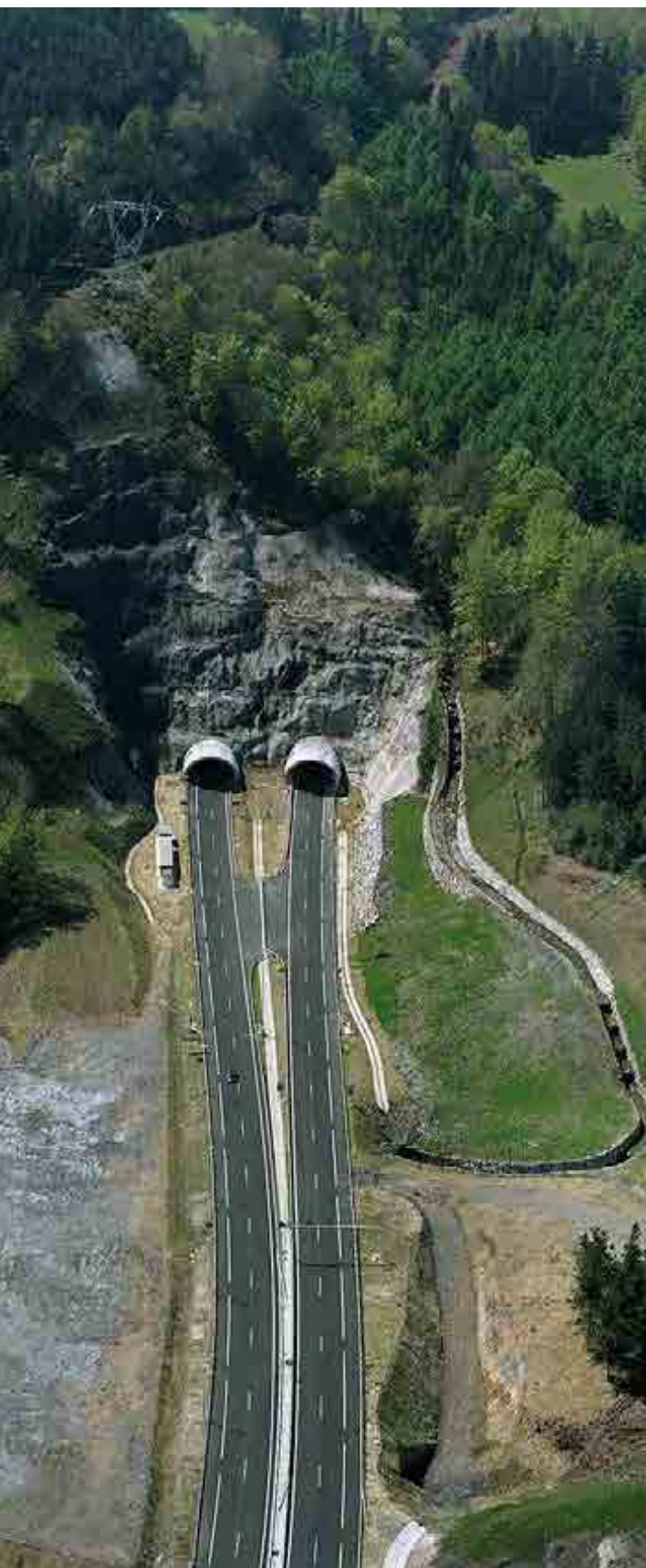
^ Túnel de Arlabán. Autopista AP-1. Tramo Arlabán-Eskoriatza. España. Arlabán Tunnel. AP-1 Toll Road. Arlabán-Eskoriatza section. Spain.
