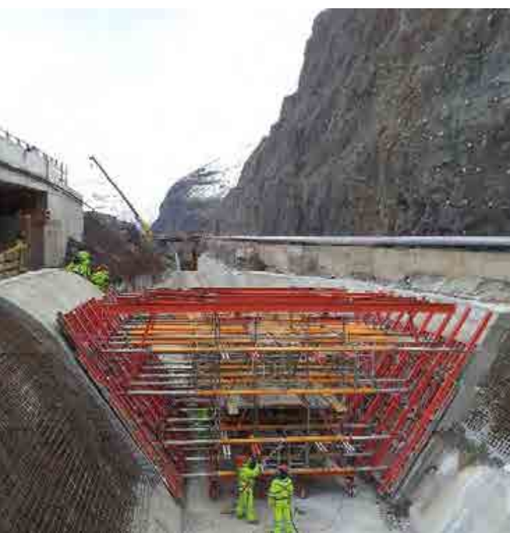
^ Obras Vertedero-Canal y Espaldón Muro. Tranque Piuquenes para Codelco. Chile. Works Dump-Channel and Wall Shoulder. Tranque Piuquenes for Codelco. Chile.
