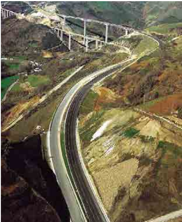
^ Autovía del Noroeste A-6. Tramo Ambasmestas-Castrolamas. España. A-6 Northwest Expressway. Ambasmestas-Castrolamas section. Spain.
