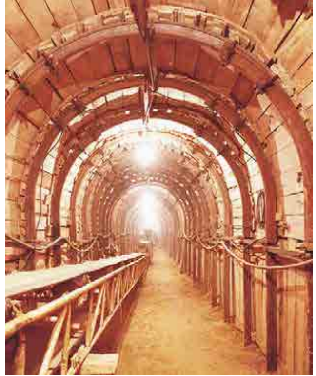
^ Túnel Metro de Madrid. Estaciones Chamartín-Fuencarral. España. Metro de Madrid Tunnel. Chamartín-Fuencarral stations. Spain.
