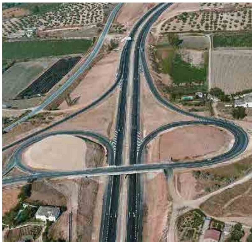
^ Autovía A-92. Variante de Loja. España. A-92 Expressway. Loja Bypass. Spain.
