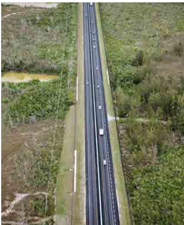
^ Ampliación de un tramo de la US-1. Estados Unidos. Expansion of a section of US-1. United States.
