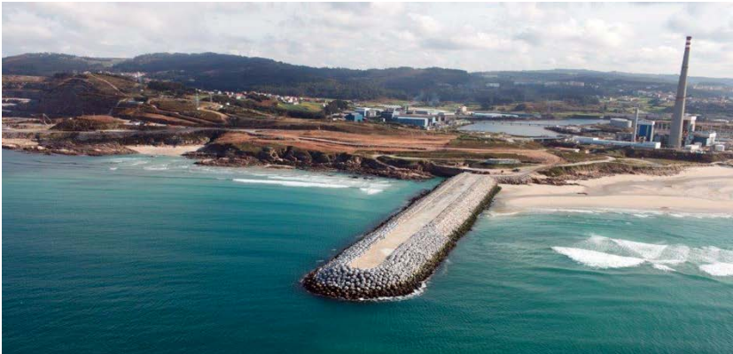
Cubípodos. Puerto Exterior Punta Langosteira. España.
