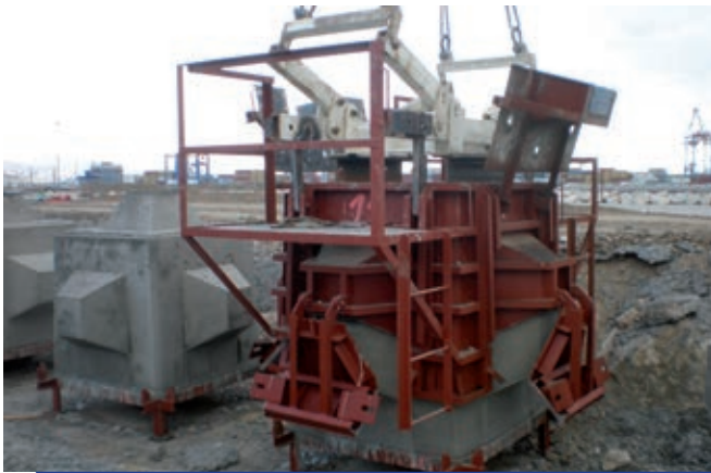
Finalización del desencofrado. End of formwork removal.
