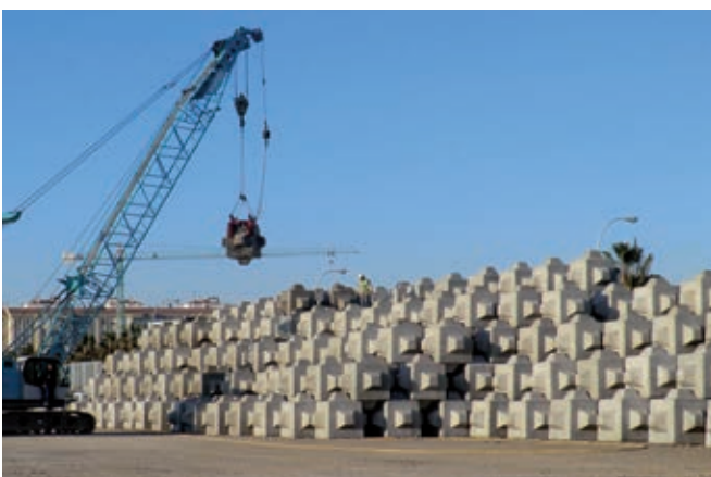
Manejo de cubípedo. Cubipod handling.
