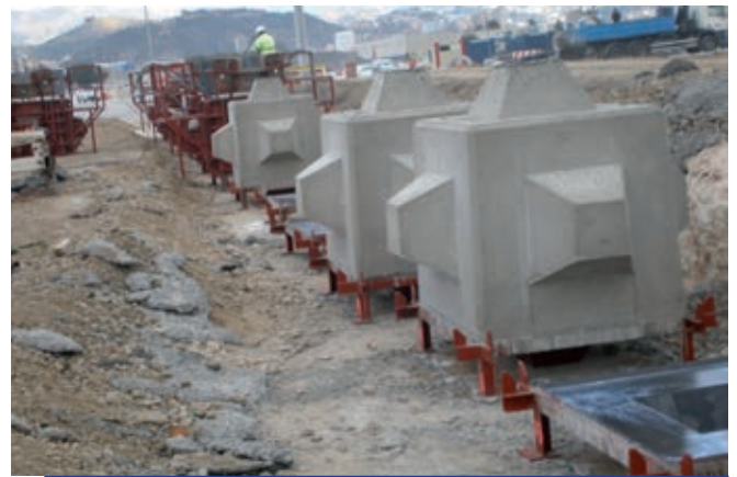
Cubípodos desencofrados. Cubipods and formwork.
