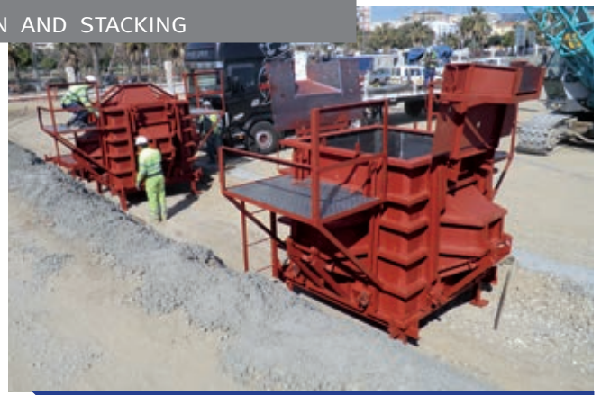
Encofrados de Cubípodos. Cubipod formwork.
