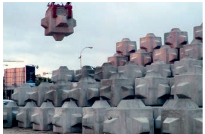
Acopio de cubípedo. Cubipod stacking.
