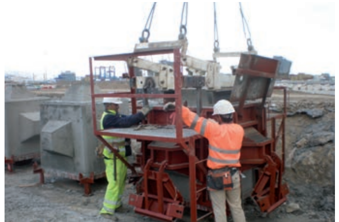
Inicio del desencofrado. Start of formwork removal.
